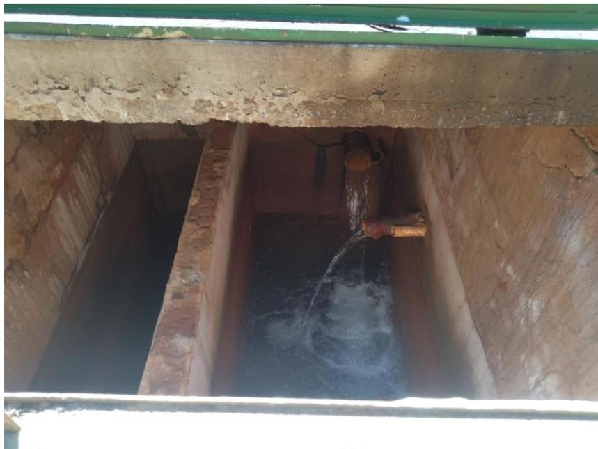
Foto 56: Entrada de água bruta no reservatório da mina.
