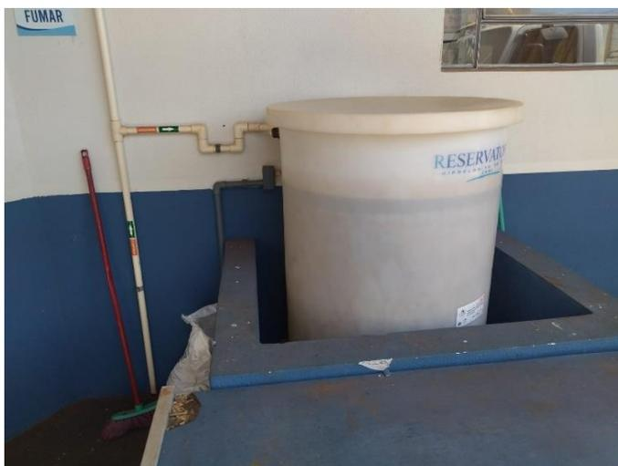
Foto 22: Tanque de armazenamento de cloro.
