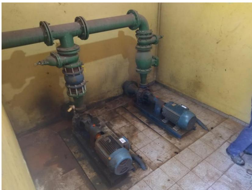
Foto 64: Conjunto moto bomba instalado.
