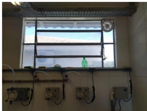
Foto 19: Bombas dosadoras e ventilação.
