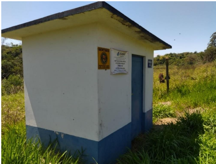
Foto 44: Abrigo da casa de comando.
