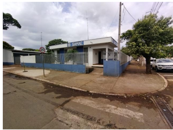
Foto 02: Falta de Acessibilidade.
