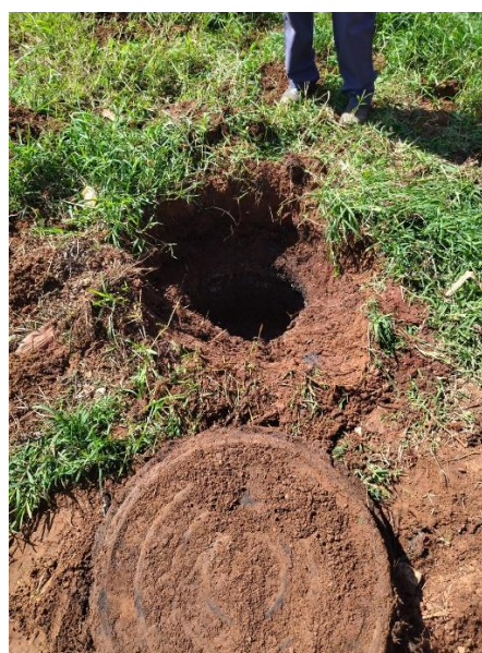
Foto 103: Vazamento aparente (proximo e Jaguafrangos). Foto 104: Situação de acesso aos PV (enterrados).
