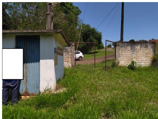
Foto 57: Estrutura e entrada do poço.
