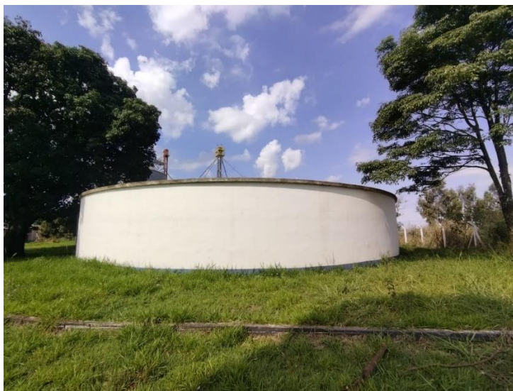
Foto 88: Reservatório apoiado 1200 m 3 .
