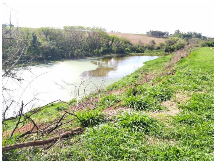
Foto 115: Presença de manchas e lodo superficial (lagoa facultativa).
