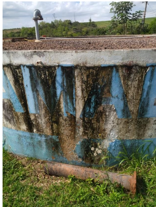
Foto 93: Vazamentos aparentes.
