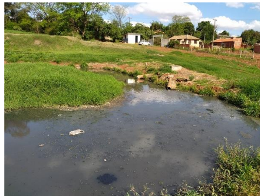
Foto 111: Lagoa Anaerobia 01 (presença de lodo flutuante) Foto 112: Lagoa Anaerobia 02 (Assoreada).
