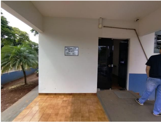
Foto 01: Fachada do empreendimento.
