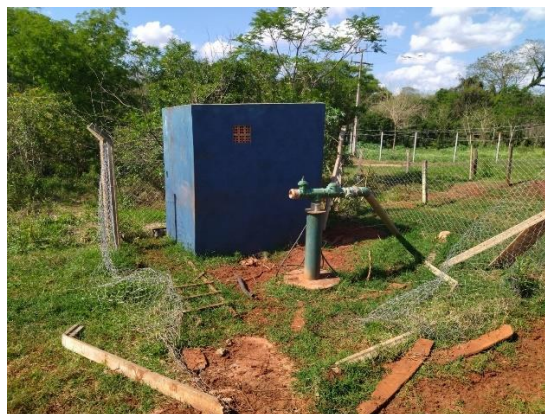
Foto 58: Acesso, falta de iluminação externa e identificação. Foto 59: Falta de cercamento adequado.
