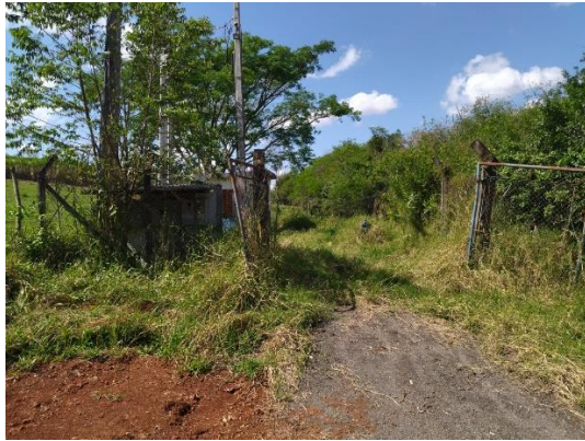
Foto 65: Acesso, portões inadequados.
