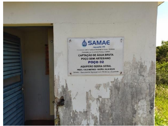
Foto 36: Identificação do poço.
