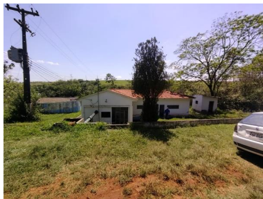
Foto 23: Vista geral ( falta de capina e manutenção).
