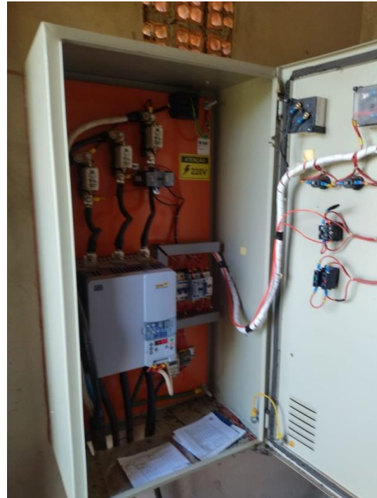
Foto 62: Ausencia de diagrama unifilar
