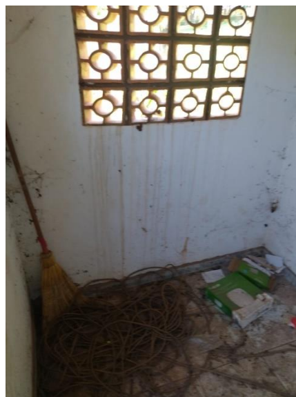
Foto 69: Ausência de limpeza e organização.
