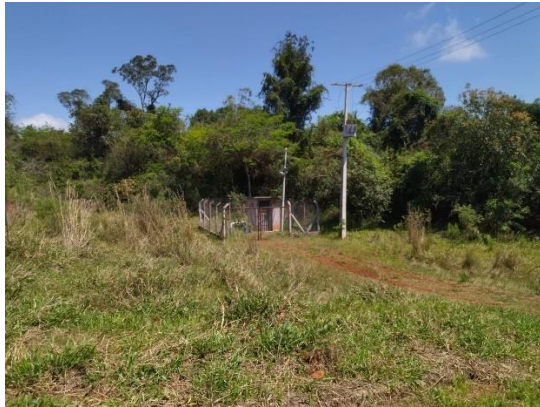
Foto 74: Acesso a área do poço 10
