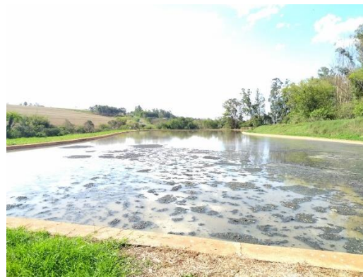
Foto 113: Presença de vegetais (Anaerobia 02). Foto 114: Falta de manutenção e remoção de lodo.
