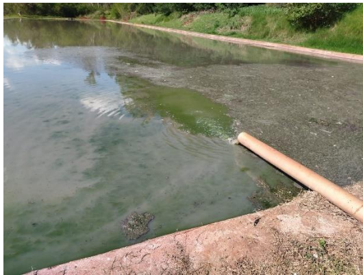
Foto 111: Lagoa Anaerobia 01 (presença de lodo flutuante) Foto 112: Lagoa Anaerobia 02 (Assoreada).
