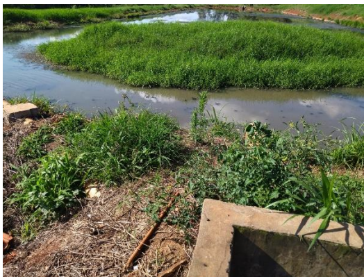
Foto 113: Presença de vegetais (Anaerobia 02). Foto 114: Falta de manutenção e remoção de lodo.
