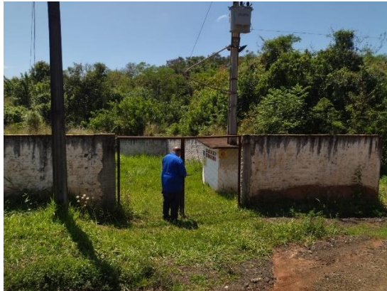
Foto 49: Acesso (sem iluminação externa).
