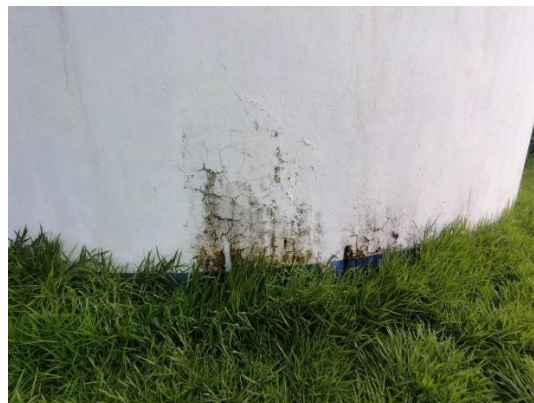
Foto 86: Vazamentos aparentes.
