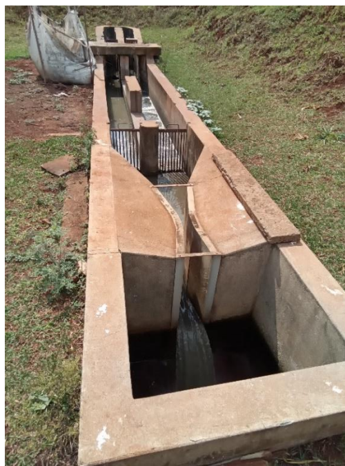
Foto 63 – Gradeamento da calha Pashall
