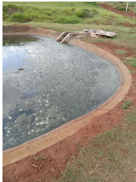
Foto 65 – Entrada da lagoa facultativa com excesso de lodo
