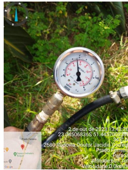
Foto 46 - Medição de pressão do ponto 01
