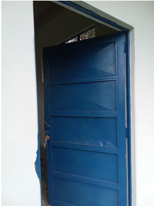
Foto 35 – Entrada da casa de comando da mina 01
