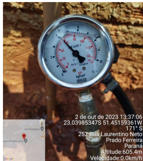
Foto 48 - Medição de pressão do ponto 02
