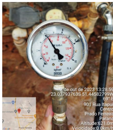
Foto 50 - Medição de pressão do ponto 03
