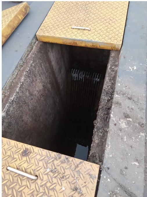
Foto 61 – Resíduos de limpeza de gradeamento dispostos de forma inadequada
