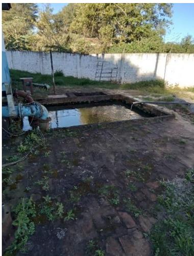
**Foto 38:** Poço de sucção EAB01 e caixa de areia
