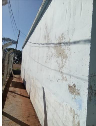
**Foto 51 – Reservatório apoiado vazamento**
