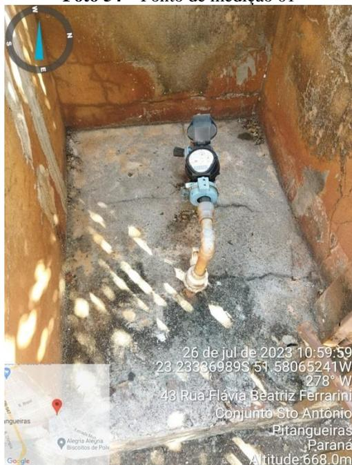
**Foto 55** – Ponto de medição 01 – Pressão 17 m.c.a
