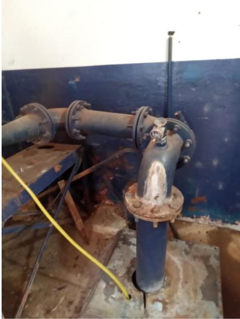
Foto 71 – Nova sala de bombas em construção
