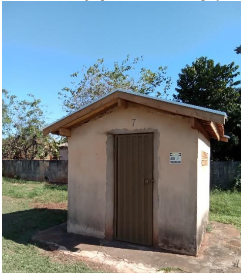
Foto 15 – Abrigo painel de controle poço 01
