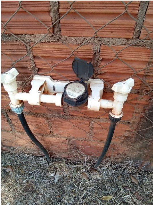
Foto 32 – Hidrômetro P02
