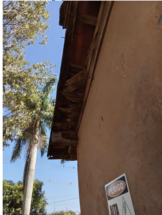
Foto 23 – Abrigo painel de comando com avarias
