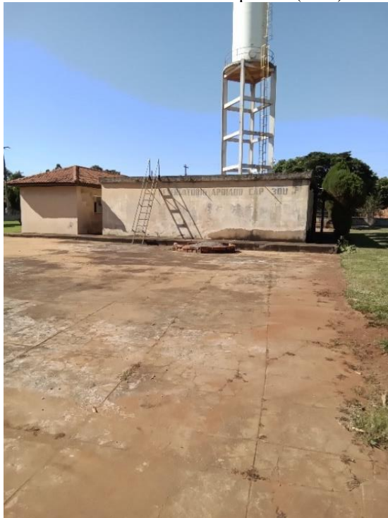
Foto 25 – Reservatório apoiado (RAP)
