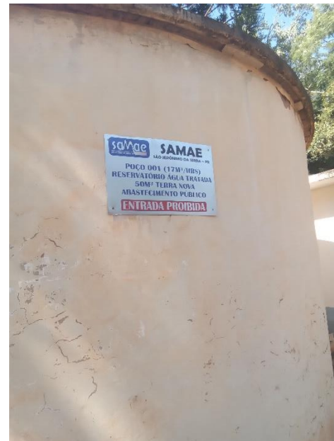
Foto 93 – Identificação da área de armazenamento de água
