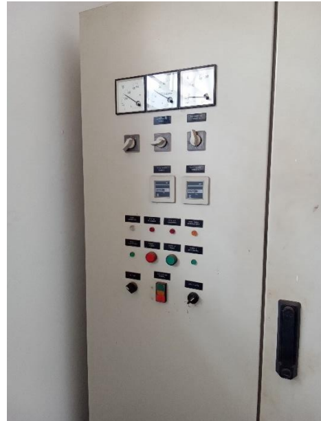
Foto 65 – Quadro de comando EEA da SEDE
