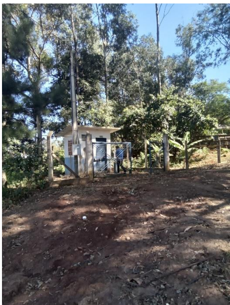
Foto 43 – Área de captação
