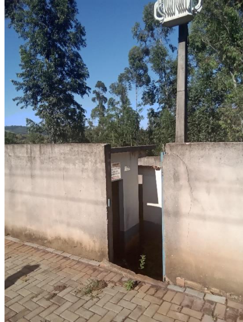
Foto 12 – Entrada da área de captação
