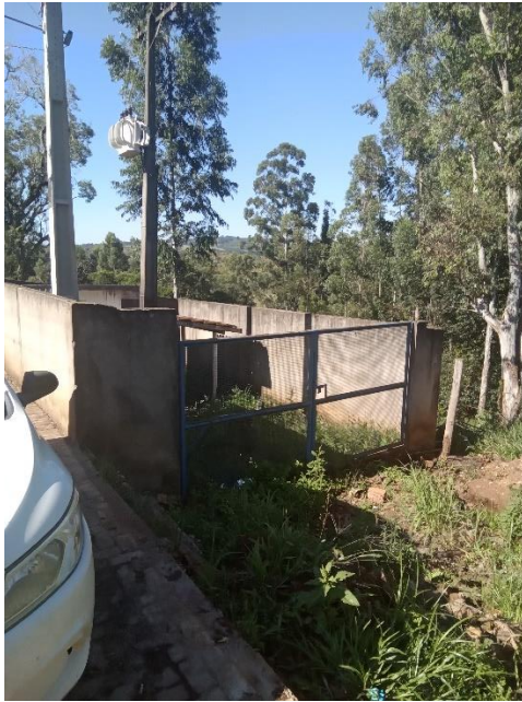
Foto 11 – Área de captação
