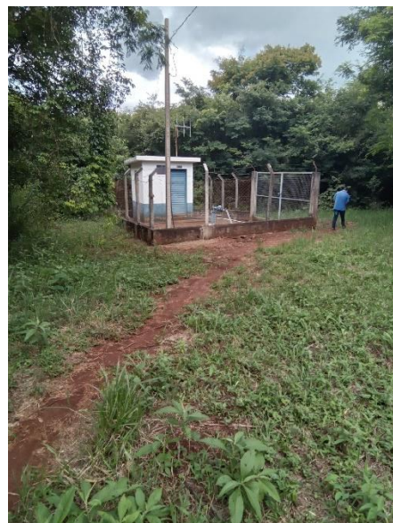
Foto 27 – Área de captação
