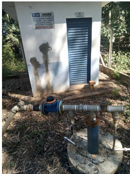
Foto 44 – Área de captação
