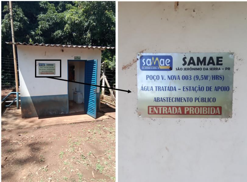
Foto 61 – Casa de comando e identificação do poço
