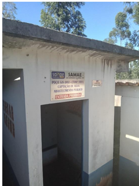
Foto 14 – Casa de comando devidamente identificada
