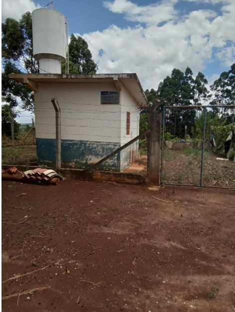
Foto 21 – Área de captação
