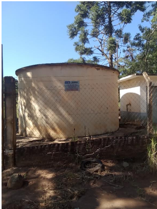
Foto 92 –Área de armazenamento de água
