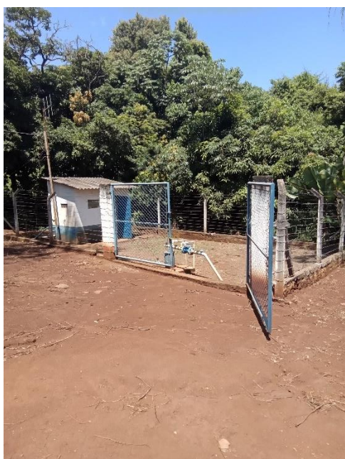
Foto 59 - Poço Vila Rural 001
