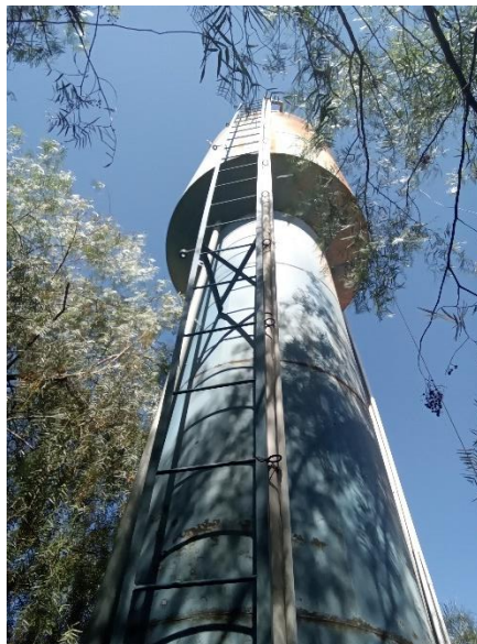
Foto 101 – Escada do REL
