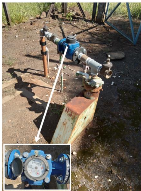
Foto 50 – Poço Vila Rural
