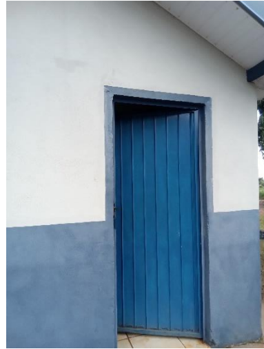
Foto 53 – Casa de comando
