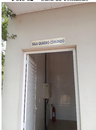
Foto 62 – Casa de comando
