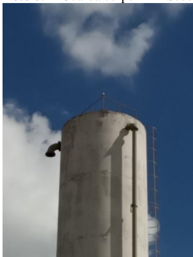
Foto 85 – Guarda corpo REL Sede
