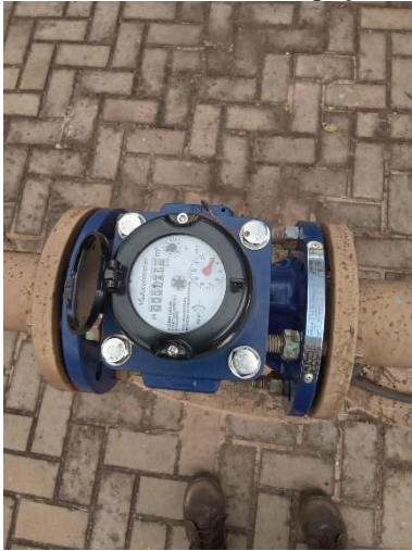
Foto 16 – Macromedidor poço 01
