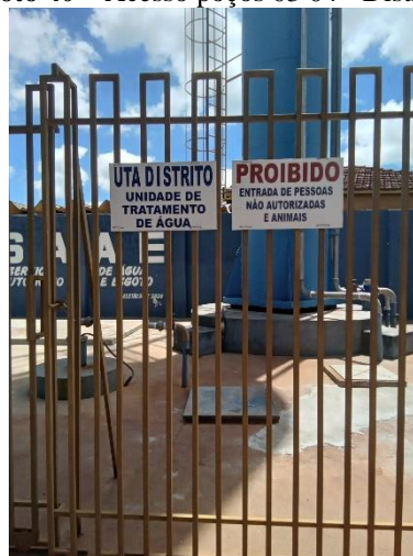
Foto 40 – Acesso poços 03 04 - Distrito
