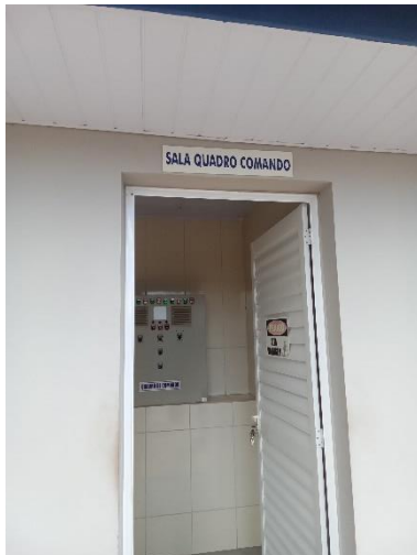
Foto 43 – Casa de comando
