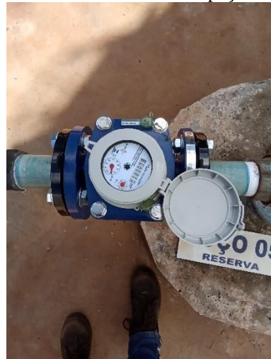
Foto 42 – Macromedidor poço 05
