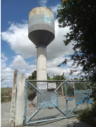
Foto 89 – Cercamento REL Vila Rural
