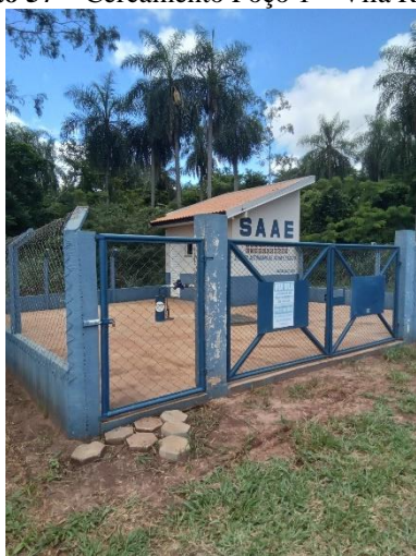
Foto 57 – Cercamento Poço 1 – Vila Rural
