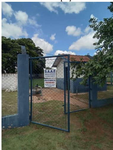
Foto 50 - Acesso poço 01 Distrito
