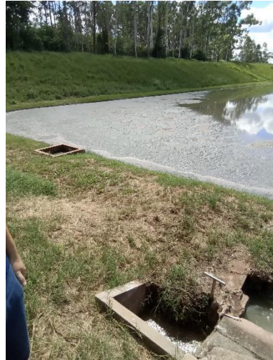
Foto 109 – Entradas anaeróbia 1
