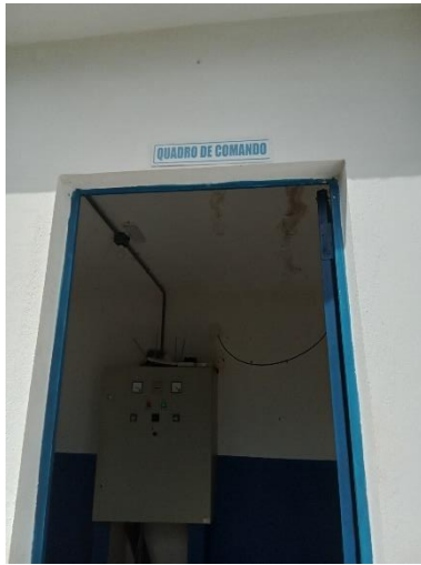
Foto 32 – Casa de comando
