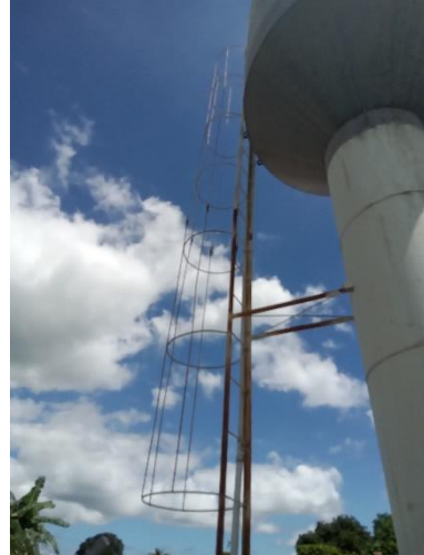
Foto 90 – Escada REL Vila Rural
