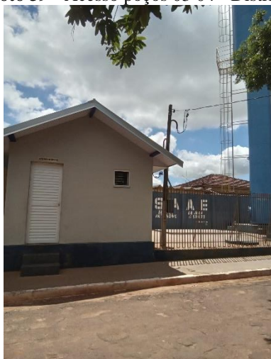
Foto 39 - Acesso poços 03 04 - Distrito
