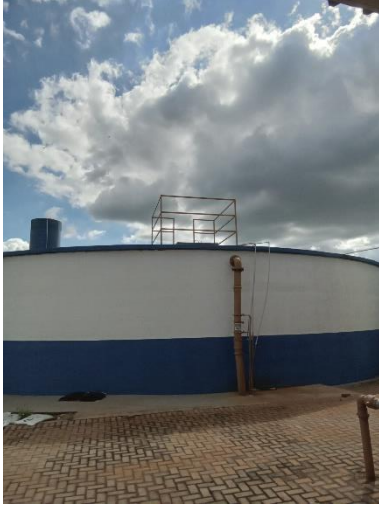
Foto 87 – Guarda corpo RAP Sede
