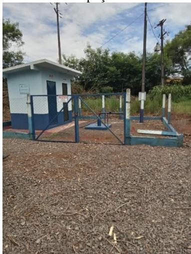
Foto 15 – Acesso poço Novo Rio do Sul
