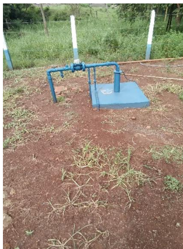
Foto 75 – Poço Arroio Guaçu
