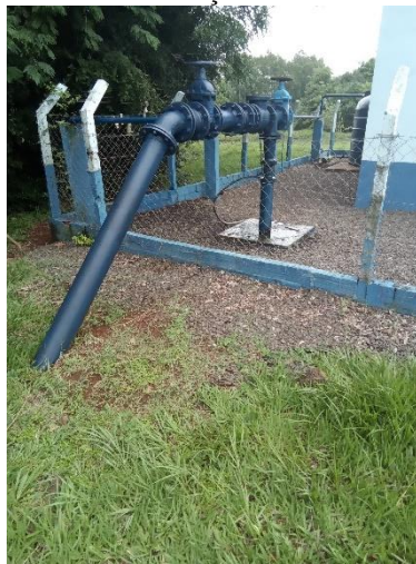
Foto 81 – Poço São Marcos
