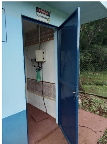
Foto 42 – Acesso casa de comando
