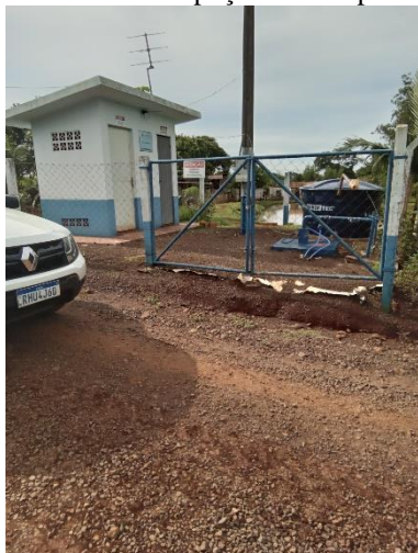
Foto 54 – Acesso poço Nova Esperança
