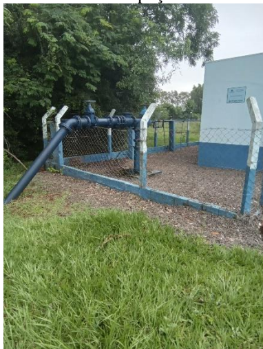
Foto 80 – Acesso poço São Marcos
