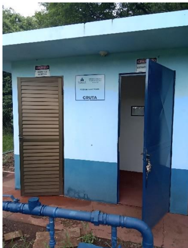
Foto 41 – Casa de comando
