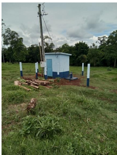
Foto 31 – Acesso poço Forquilha
