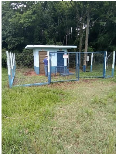
Foto 39 – Acesso poço linha Gruta
