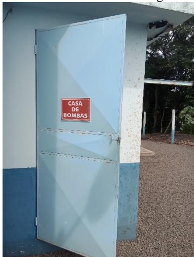
Foto 130 – Elevatória mina Sanga mineira
