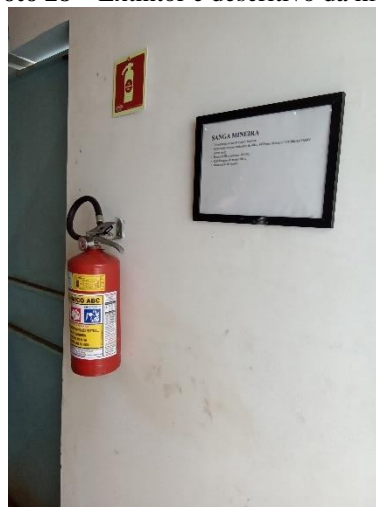
Foto 28 – Extintor e descritivo da mina
