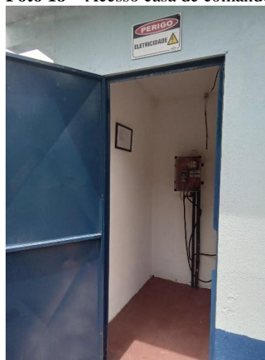
Foto 18 – Acesso casa de comando
