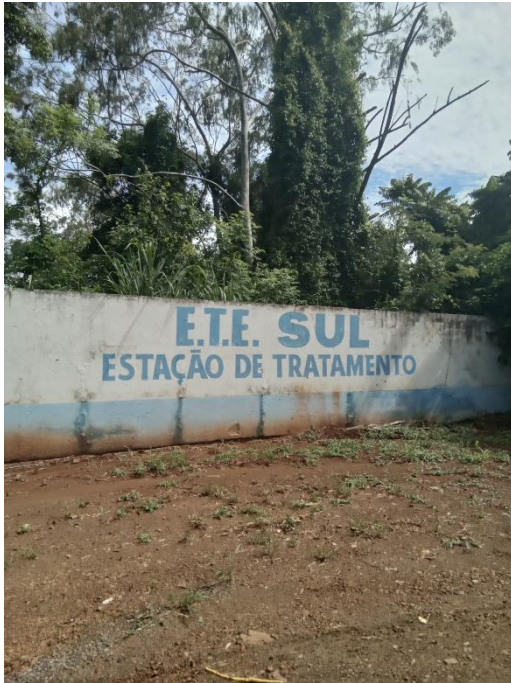
Foto 167 – Identificação e acesso à ETE
