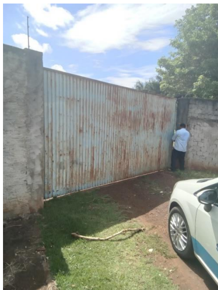
Foto 26 – Acesso ao poço
