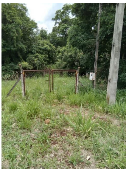
Foto 46 – Acesso poço Itaúna
