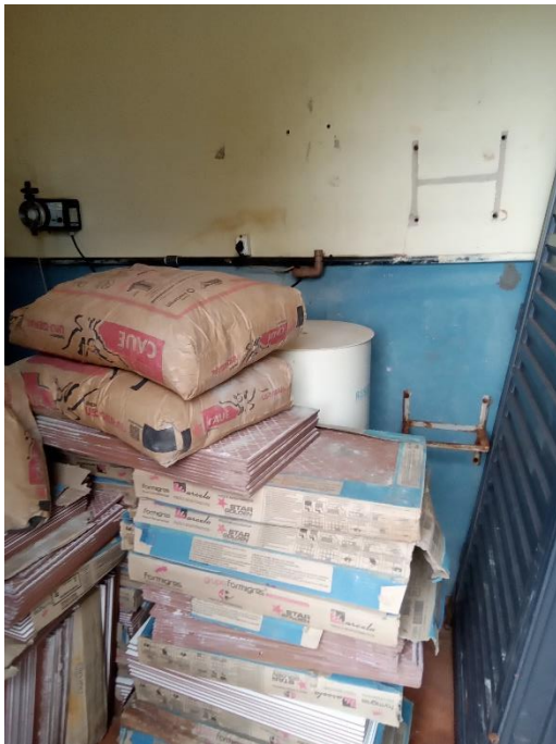
Foto 90 – Reforma em andamento da UTA
