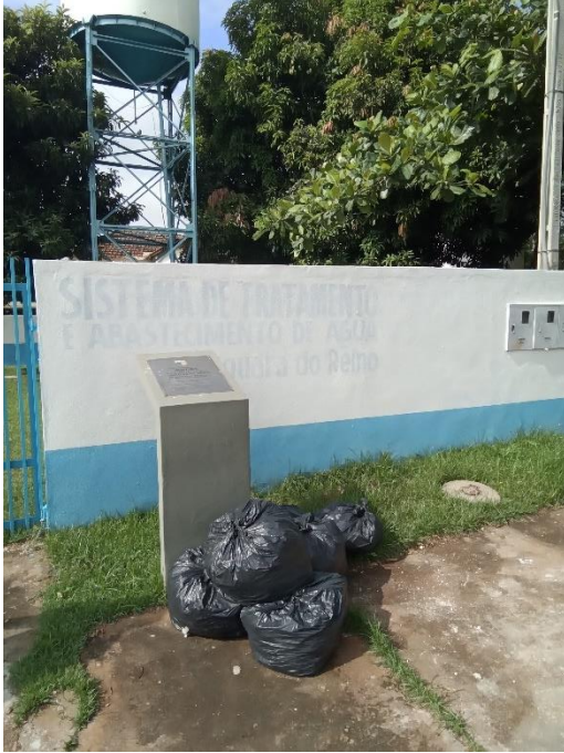
Foto 32 – Identificação e acesso ao poço
