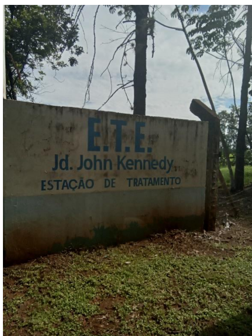
Foto 176 – Identificação e acesso à ETE
