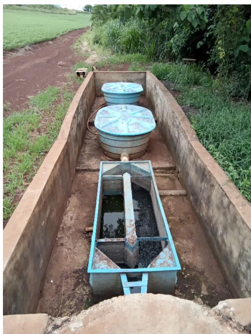
Foto 200 – Gradeamento/ desaneração/calha Parshall
