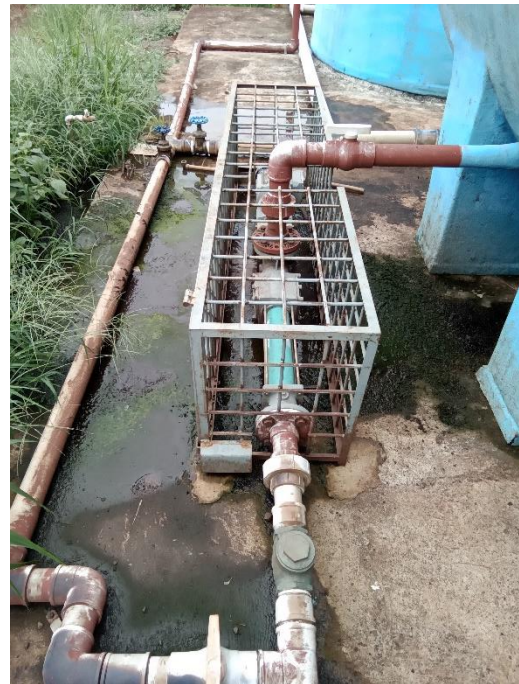
Foto 205 – Vazamentos aparentes
