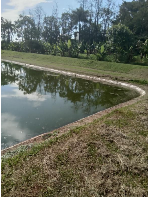
Foto 178 – Talude lagoa anaeróbia
