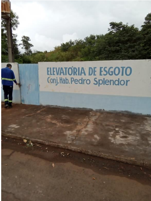
Foto 158 – Acesso e identificação
