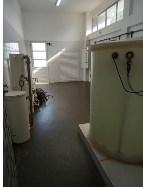
Foto 78 – Tanque de solução com cloro
