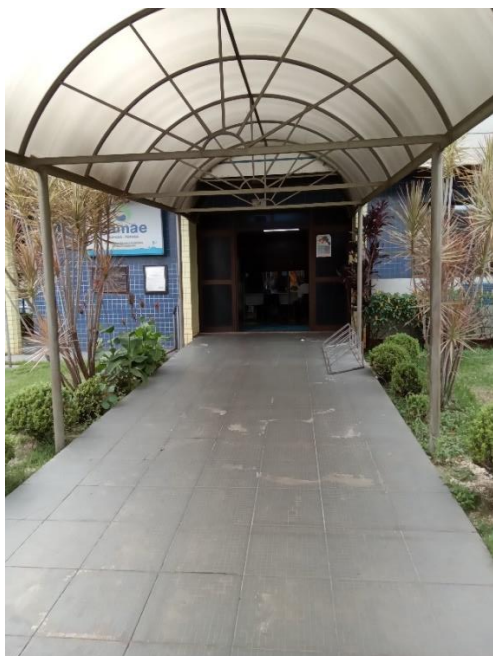
Foto 01 – Acesso área de atendimento ao público
