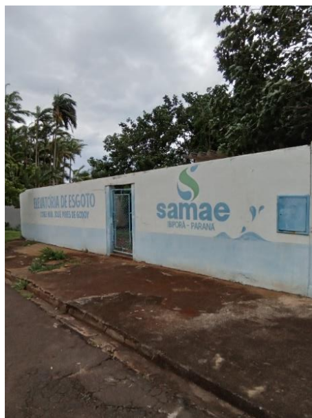
Foto 166 – Acesso e identificação
