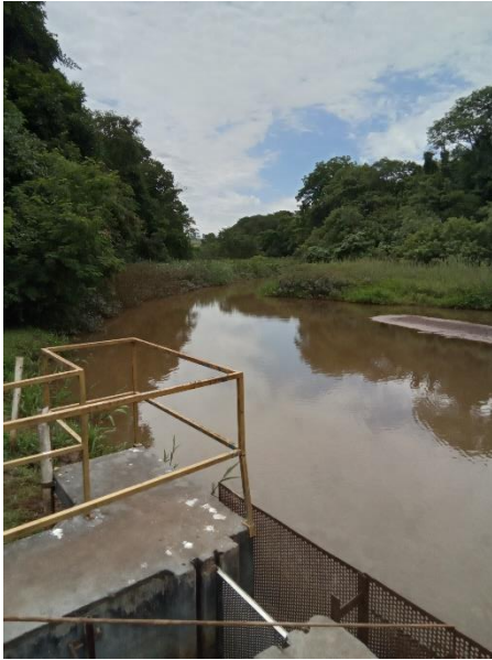
Foto 20 – Ponto de captação
