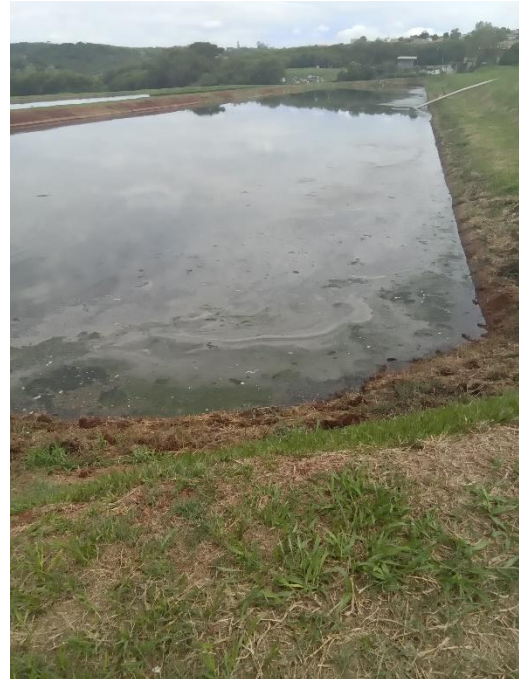
Foto 191 – Talude lagoa anaeróbia 1
