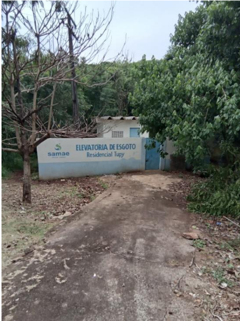
Foto 164 – Acesso e identificação
