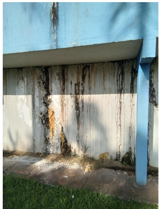
Foto 122 – Sinais de vazamento
