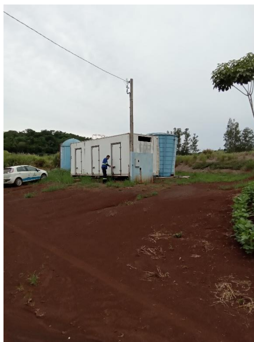
Foto 201 – Acesso à ETE
