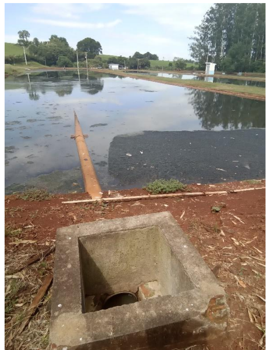
Foto 170 – Entrada lagoa anaeróbia 1
