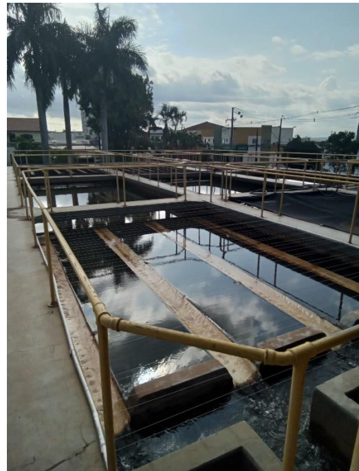
Foto 63 – Floculadores hidráulicos
