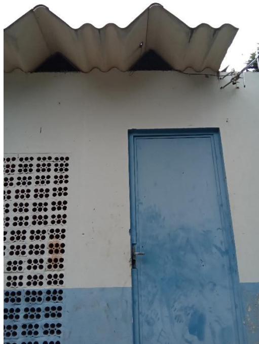
Foto 160 – Casa de comando
