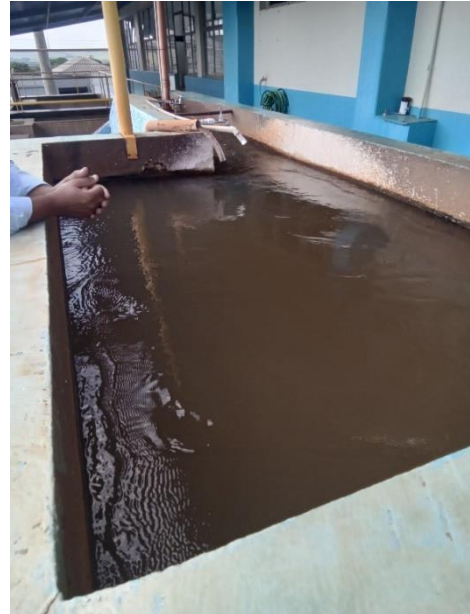
Foto 63 – Floculadores hidráulicos
