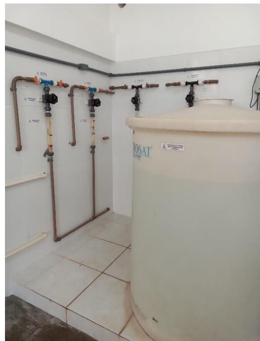
Foto 78 – Tanque de solução com cloro
