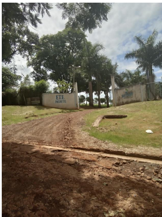
Foto 184 – Acesso à ETE
