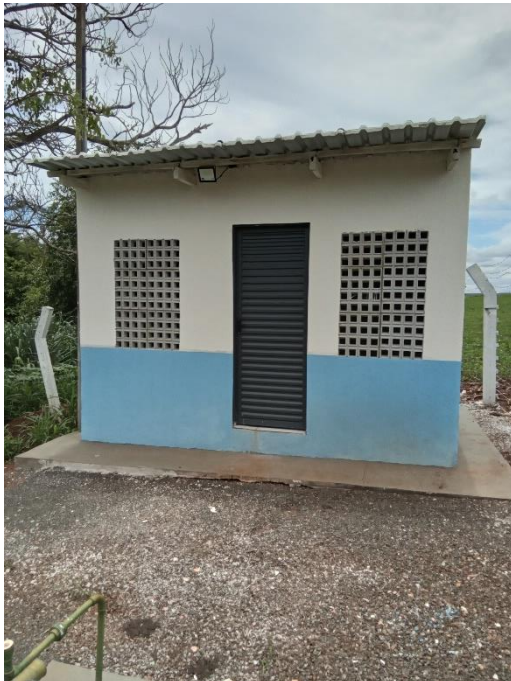
Foto 50 – Casa de comando
