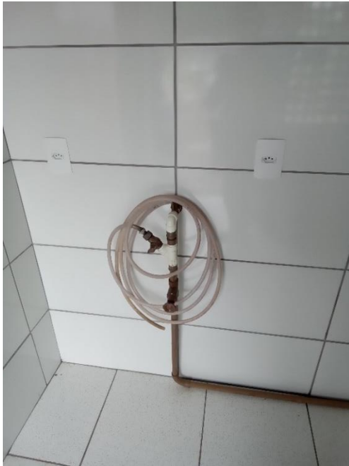
Foto 52 – Tomada de coleta de água
