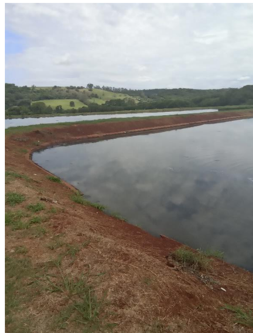
Foto 193 – Talude lagoa anaeróbia 2
