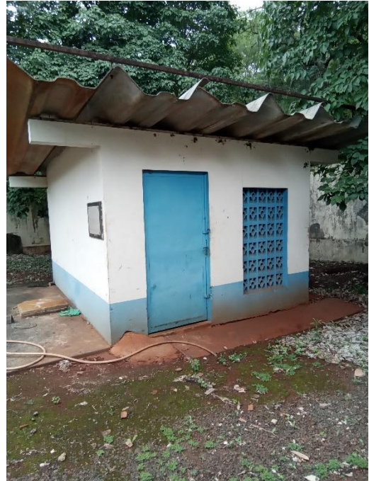
Foto 159 – Casa de comando
