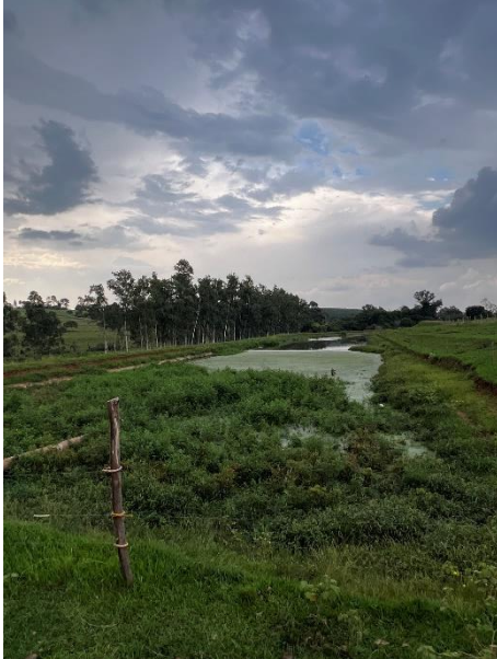
Foto 97 – Eutrofização, vegetação, assoreamento e danos estruturais lagoa facultativa 01
