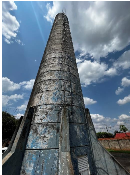
Foto 67 – Escada de acesso REL
