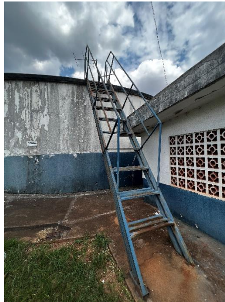
Foto 61 – Escada de acesso ao RAP
