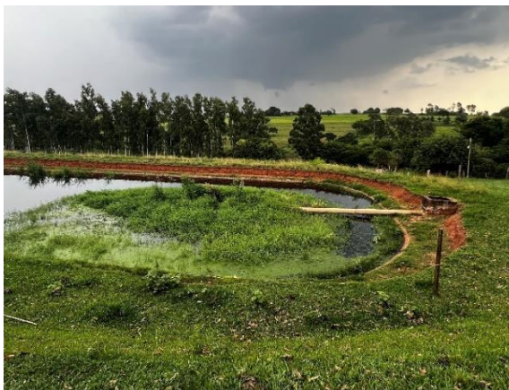
Foto 90 – Entrada lagoa anaeróbia 01 – problemas estruturais, assoreamento e vegetação dentro da lagoa
