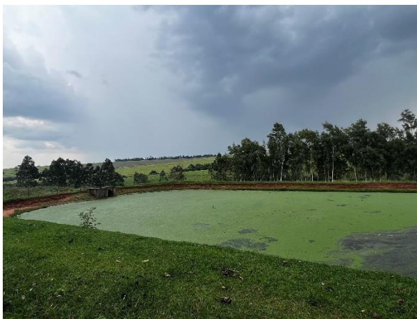
Foto 92 – Eutrofização lagoa anaeróbia 01
