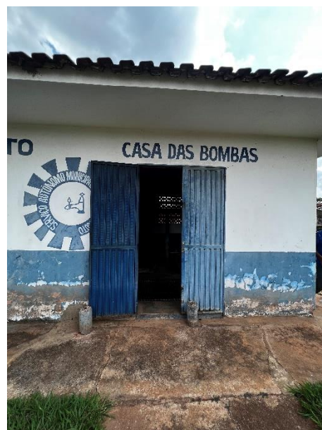
Foto 50 – Entrada casa de comando
