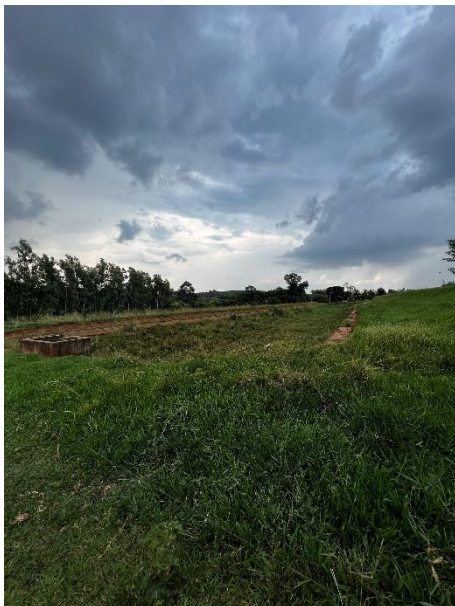
Foto 95 – Lagoa anaeróbia 02 – inativa
