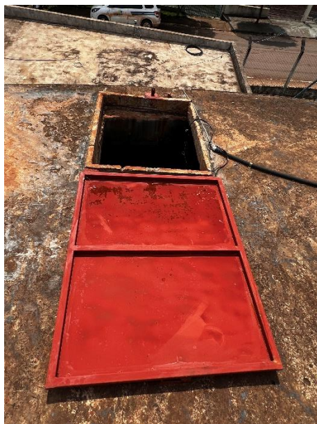
Foto 62 – Abertura para inspeção
