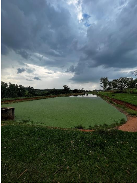
Foto 93 – Eutrofização lagoa anaeróbia 01
