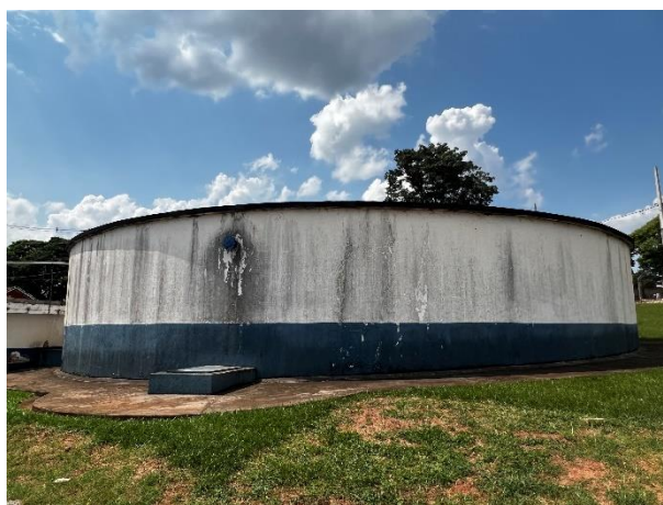
Foto 64 – Tela de proteção instalada
