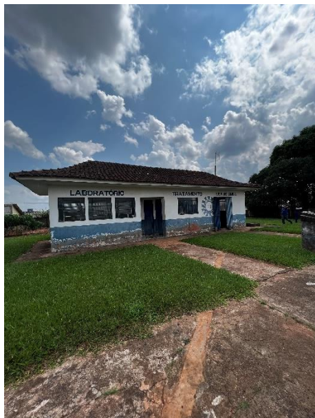
Foto 21 – Unidade de tratamento 02 (laboratório não está sendo utilizado neste local)
