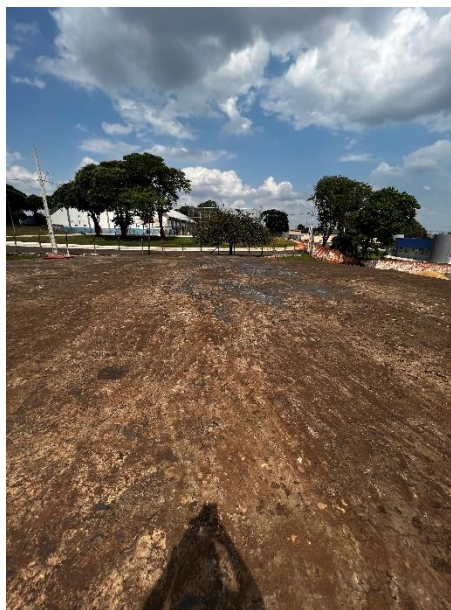
Foto 63 – Sem guarda corpo próximo a abertura de inspeção
