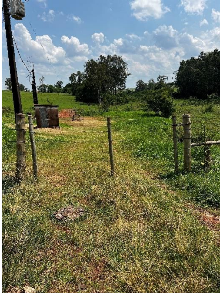
Foto 29 – Falta de identificação acesso poço 1
