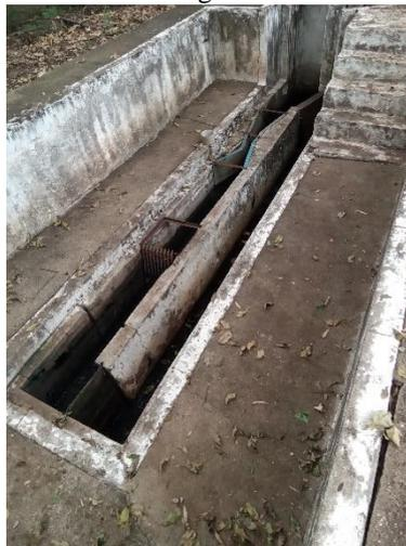
**Foto 123** – Gradeamento e calha parshall
