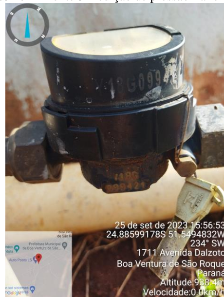
Foto 107 – Ponte 3 medição de pressão - ano 2018
