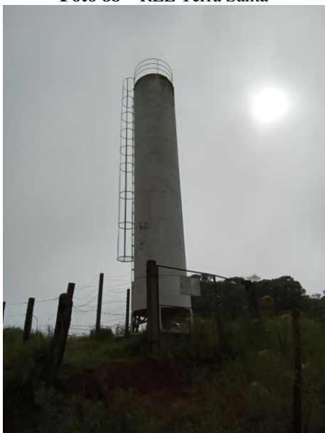
Foto 88 – REL Terra Santa
