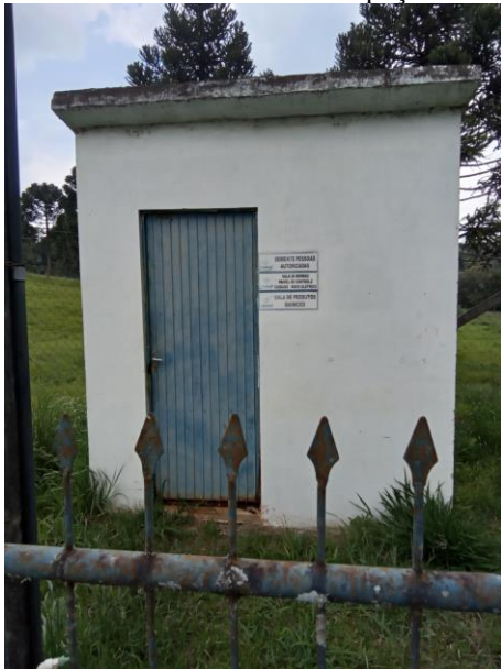
Foto 56 – Casa de comando poço sítio
