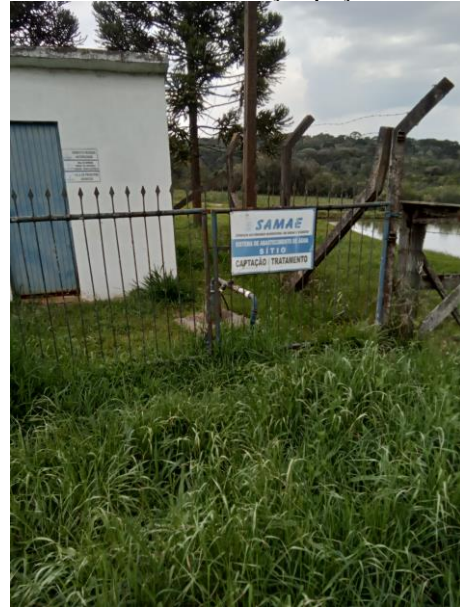
Foto 55 – Identificação poço sítio
