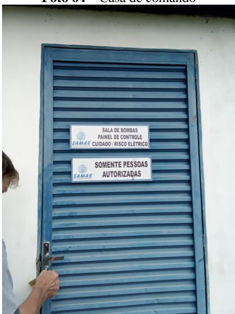
Foto 64 – Casa de comando
