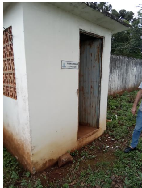
Foto 28 – Casa de comando
