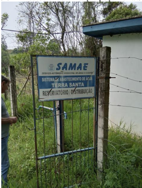
Foto 62 – Acesso e identificação poço Terra Santa
