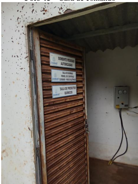
Foto 41 – Casa de comando
