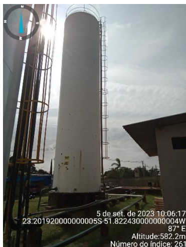
Foto 50 - Reservatório elevado (SEDE)
