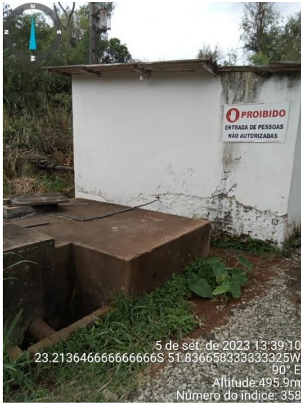
Foto 56 - Caixa de inspeção
