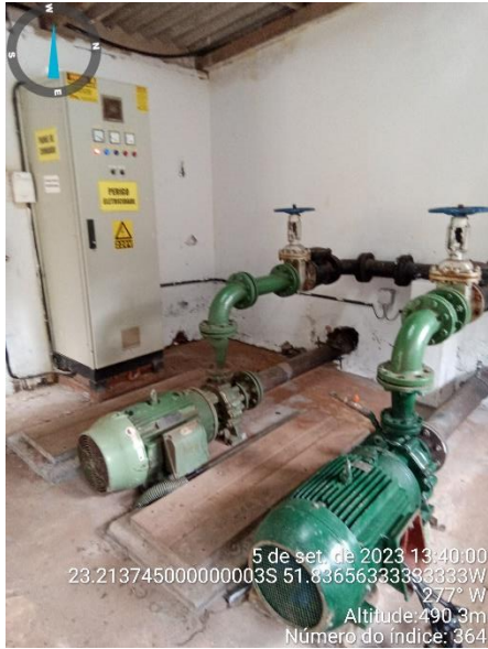
Foto 45 - Interior da casa de comendo da mina
