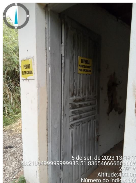
Foto 44 - Entrada da casa de comando da Mina 01
