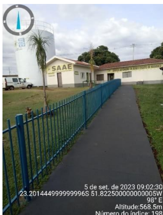
Foto 17 - Cercamento interno dos poços e reservatório
