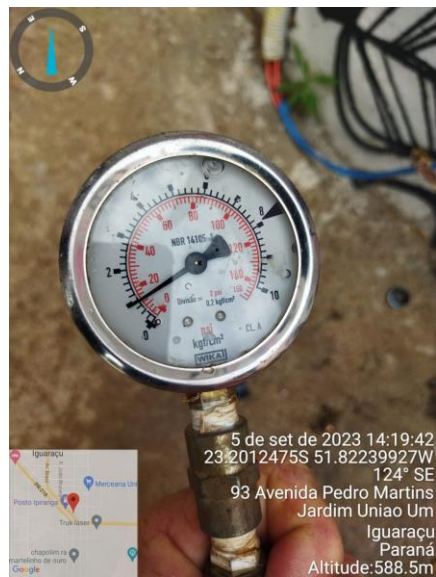
Foto 59 - Medição de pressão do ponto 1
