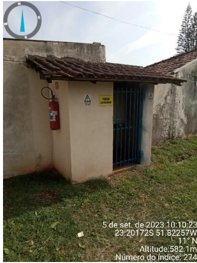
Foto 19 - Casa de comando
