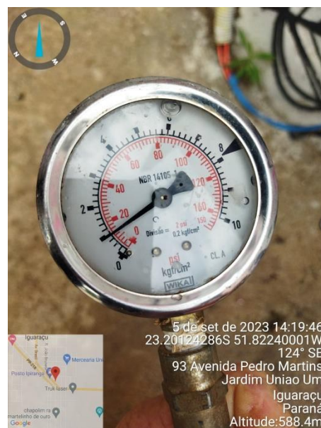
Foto 61 - Medição de pressão do ponto 2
