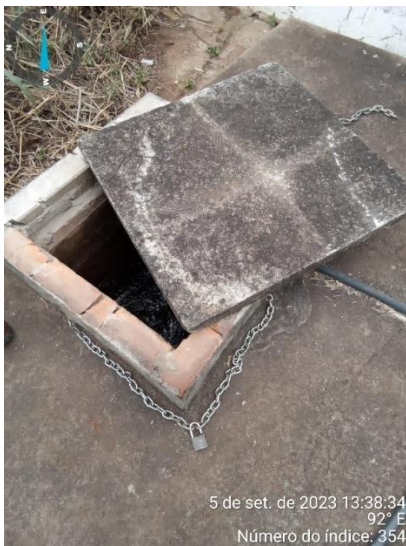
Foto 56 - Caixa de inspeção
