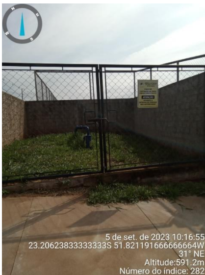
Foto 33 - Área do poço 04
