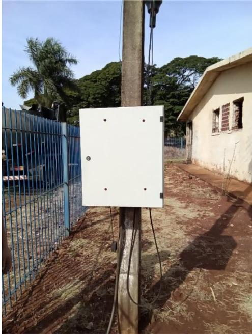
Foto 62 – Quadro de comando poço IBC
