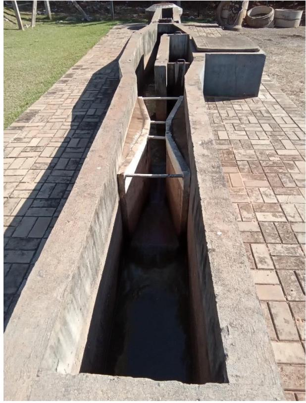
**Foto 64 – Gradeamento elevatória 02**
