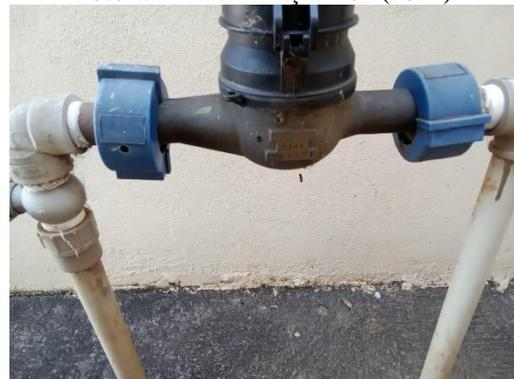
**Foto 61** - Hidrômetro P03 – P = 20.60 m.c.a
