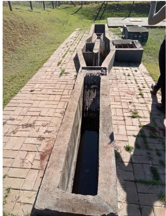
**Foto 68 - Calha Parshall Elevatória 01**
