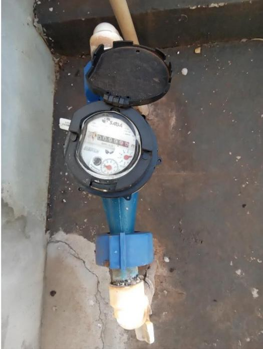
**Foto 55 - Hidrômetro P01 – P= 30,00 m.c.a**
