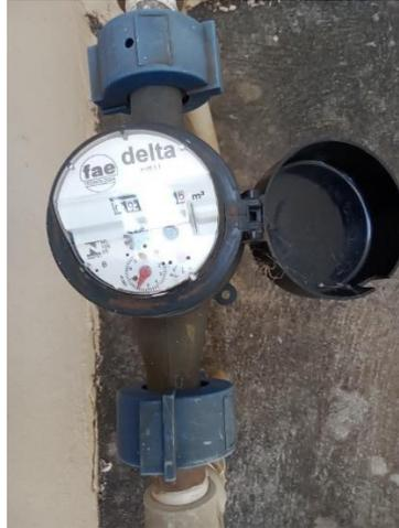
**Foto 58** – Hidrômetro P02 P= 33,05m.c.a
