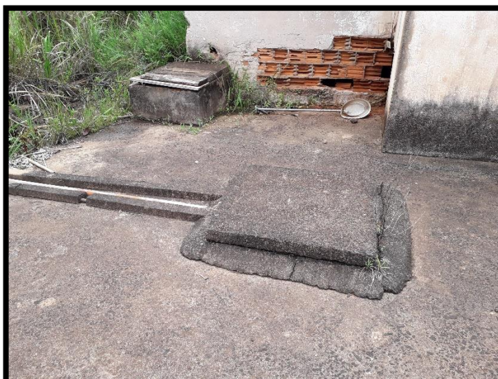
Imagem 3: abertura de inspeção do reservatório de água da mina
