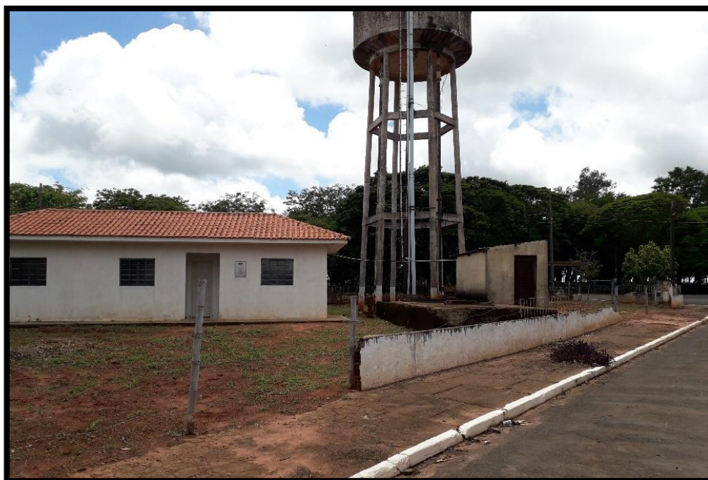
Imagem 6: perímetro dos reservatórios e unidade de tratamento
