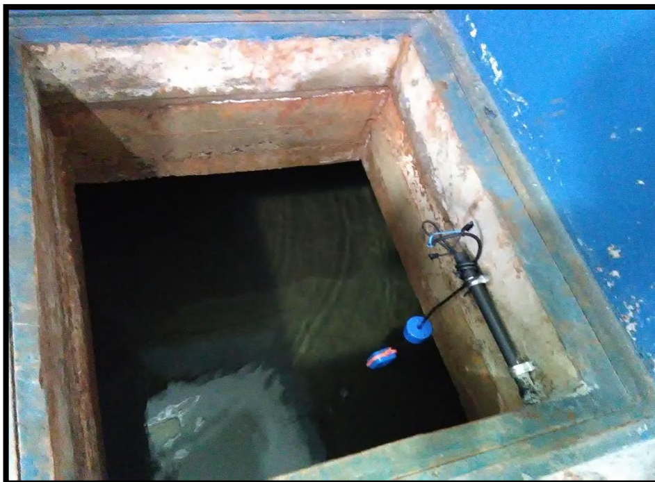
Imagem 07: Abertura de inspeção do reservatório enterrado
