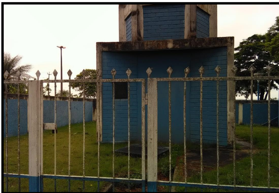
Imagem 08: Entrada do perímetro do reservatório elevado
