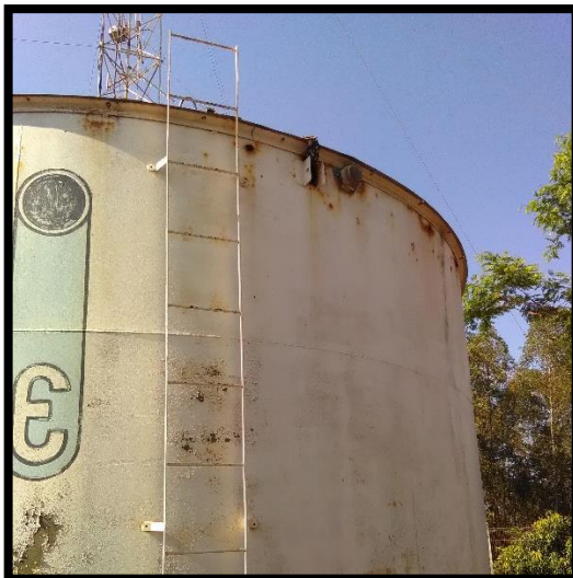
Imagem 10: RAP 01 (Recalque Gaúcha)
