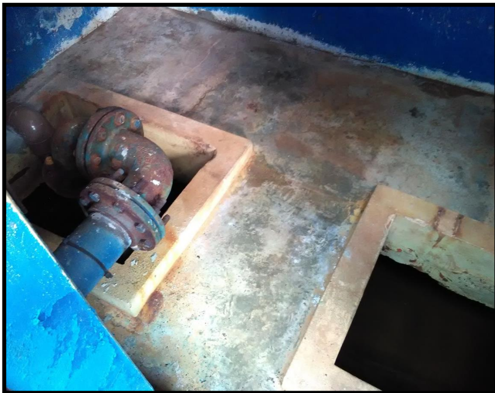
Imagem 09: Abertura de inspeção do reservatório enterrado
