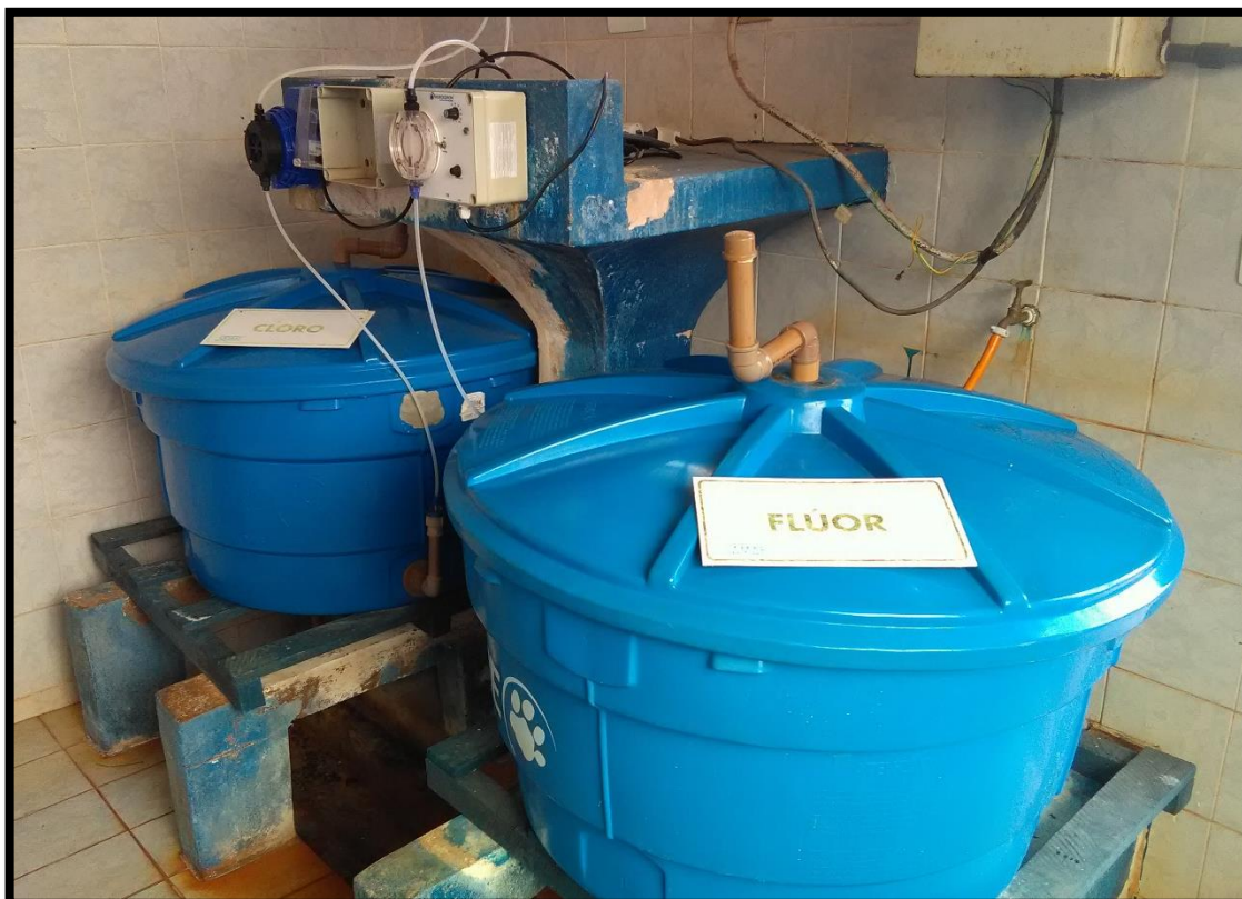
Imagem 07: Bombas dosadoras e reservatório de solução
