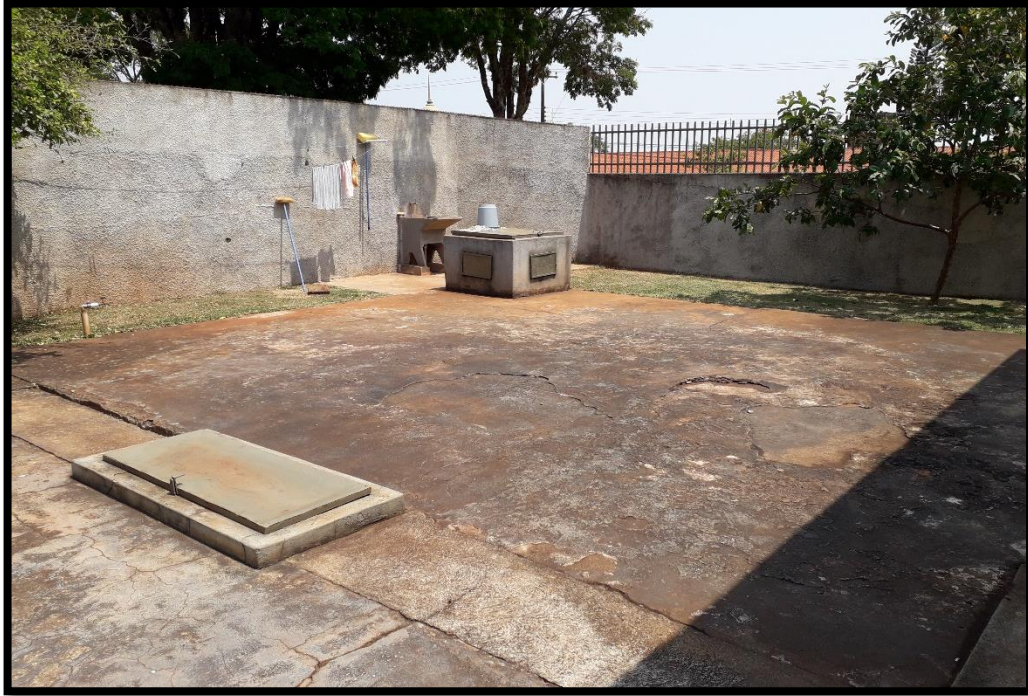
Imagem 4: Aberturas de Inspeção do Reservatório enterrado
