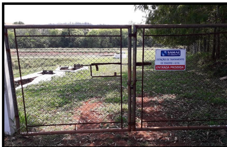
Imagem 19: Portão de acesso da ETE
