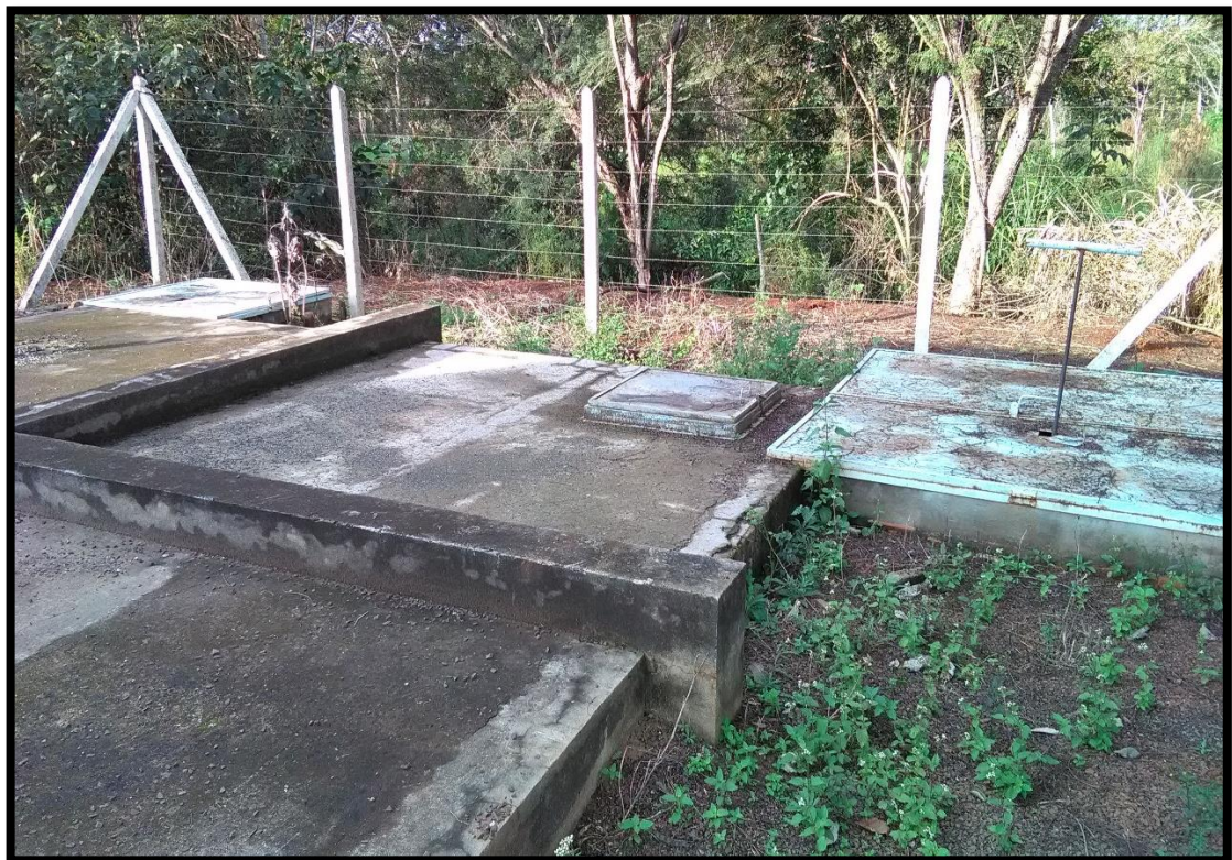
Imagem 04: Reservatório de acumulação da mina
