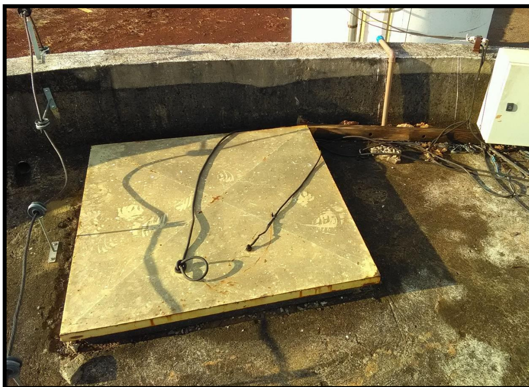
Imagem 08: Abertura de inspeção do reservatório apoiado
