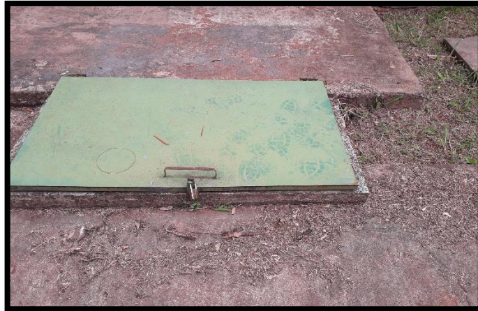
Imagem 1: Reservatório de água da mina e do poço 2
