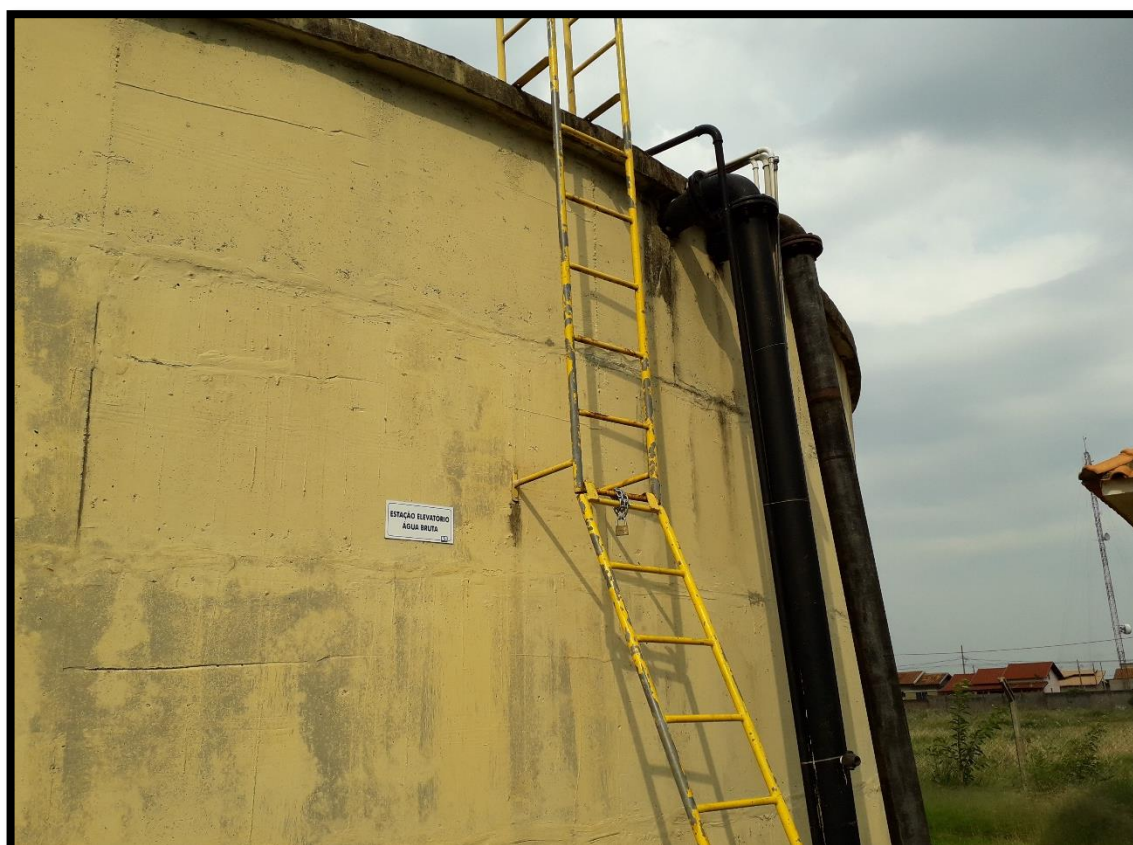
Imagem 7: Reservatório apoiado de 800m³
