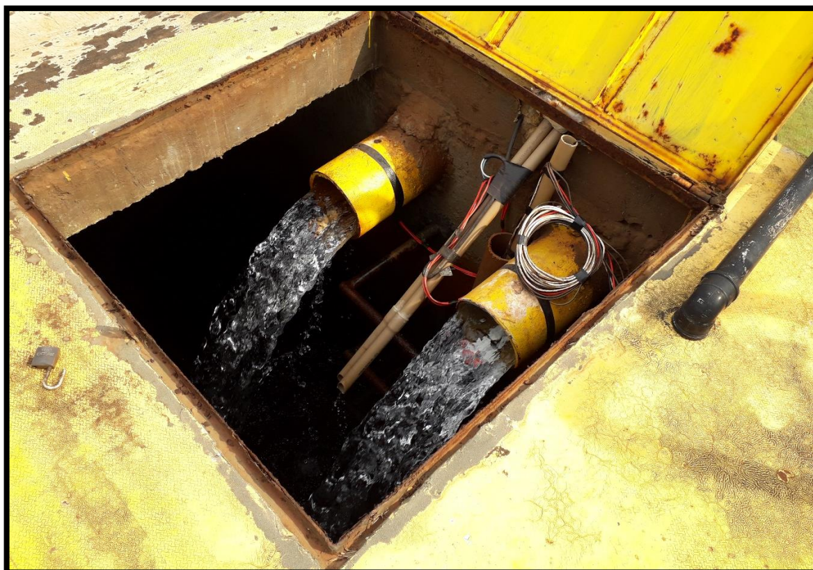
Imagem 8: abertura de inspeção do Reservatório apoiado de 800m 3
