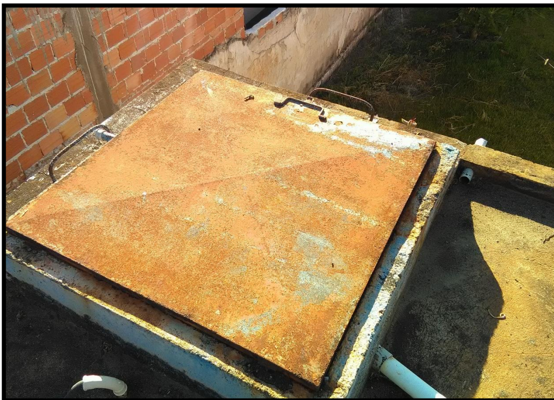
Imagem 06: Abertura de inspeção do reservatório apoiado 01
