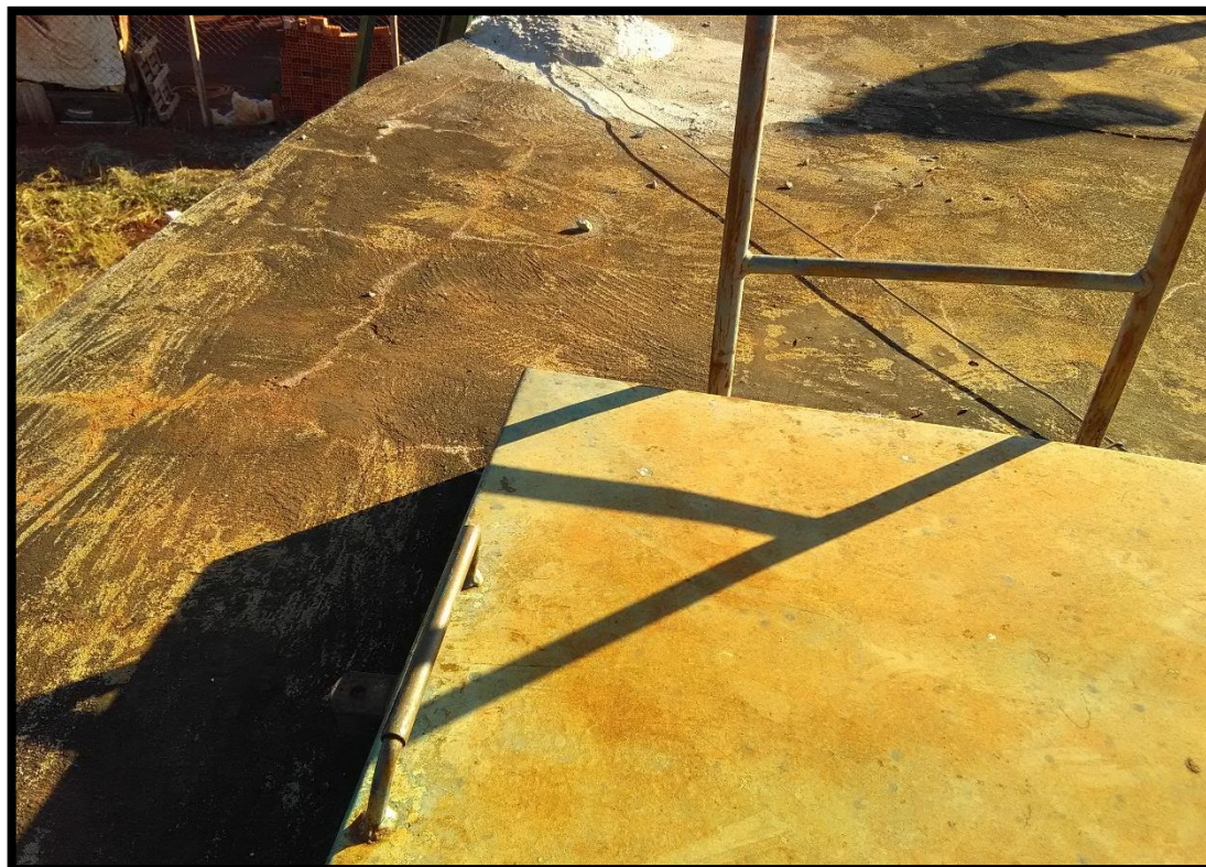
Imagem 08: Abertura de inspeção do reservatório apoiado 02
