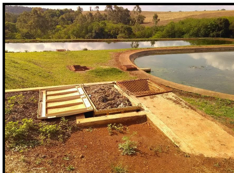
Imagem 23: Tanque de resíduos removidos do gradeamento
