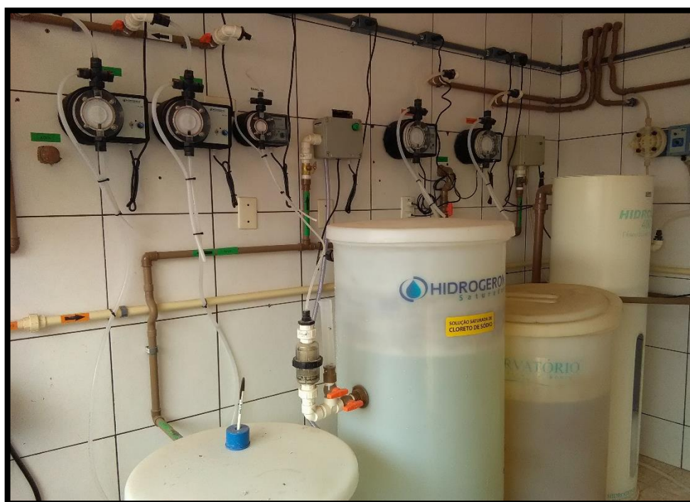
Imagem 13: Reservatórios e dosadoras de cloro e fluor
