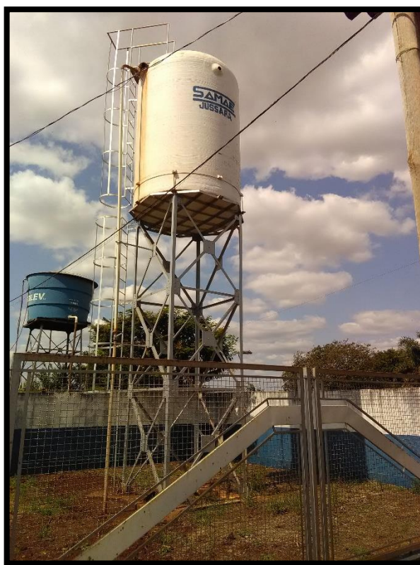
Imagem 12: Reservatório elevado da vila rural
