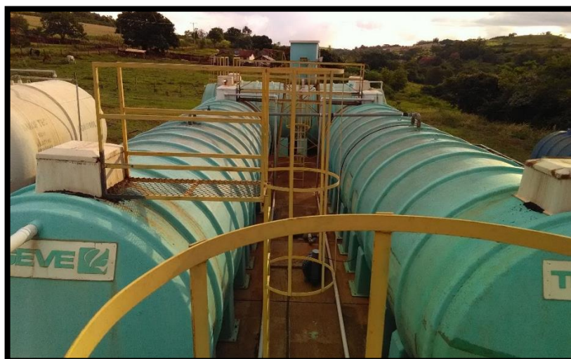
Imagem 24: Tanques reatores
