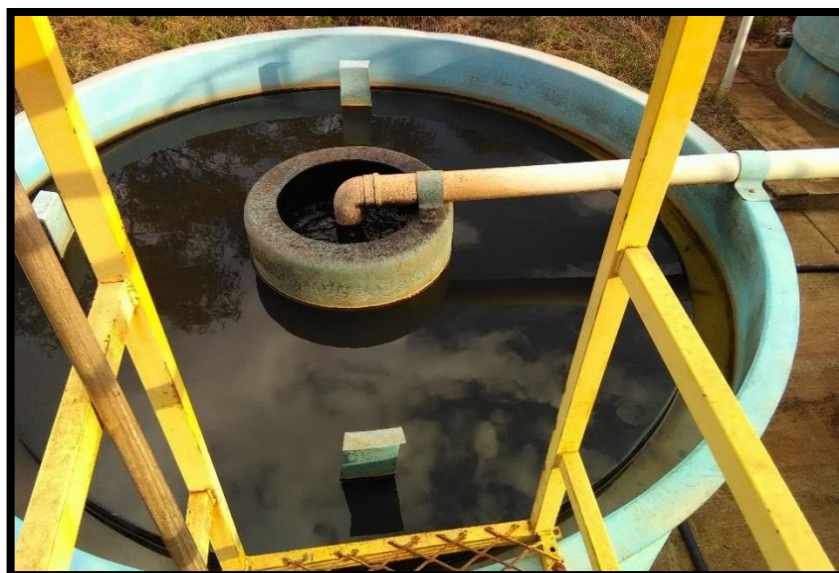
Imagem 25: Tanque decantador
