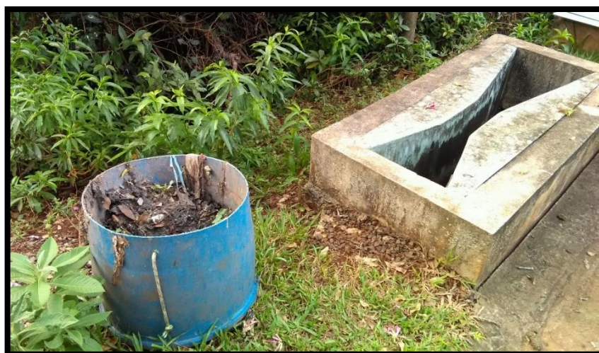
Imagem 22: Calha parshal com régua ilegível
