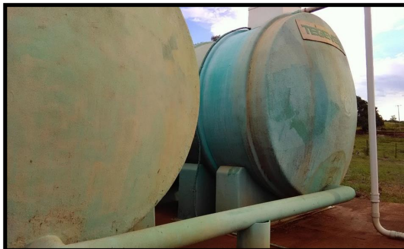
Imagem 23: Tanques de Equalização
