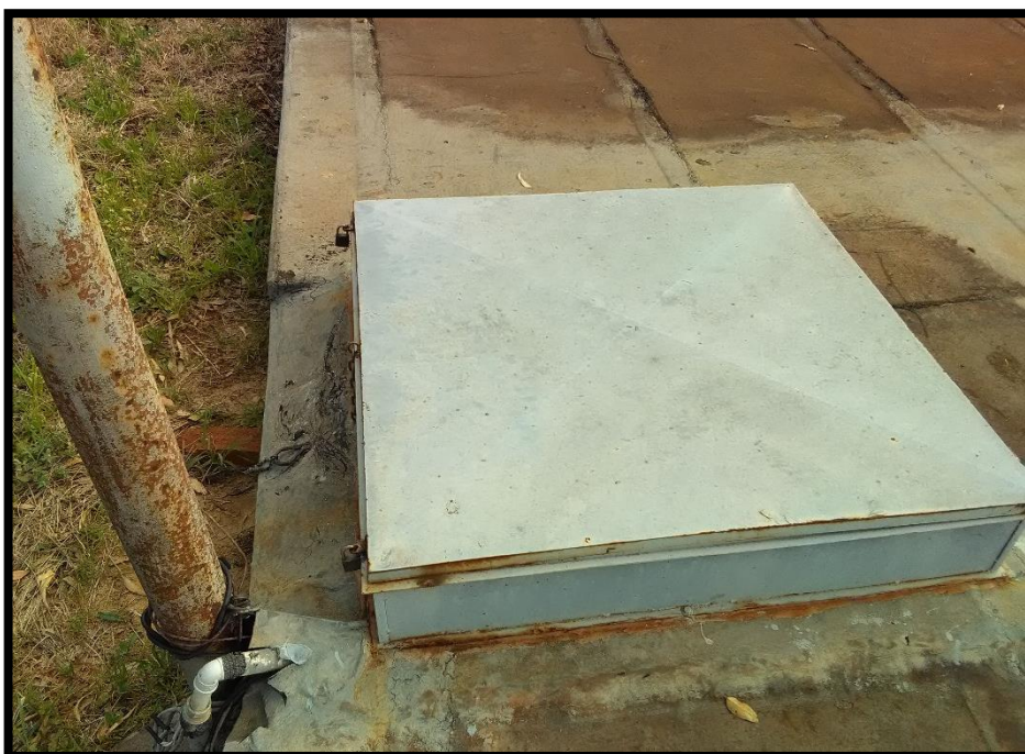
Imagem 5: abertura de inspeção do Reservatório semienterrado
