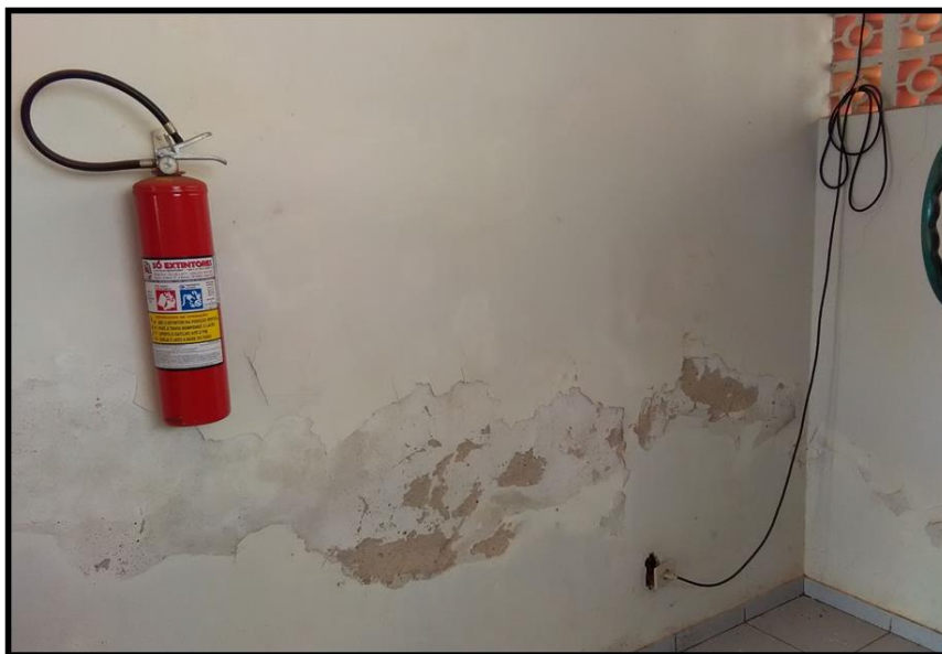
Imagem 28: Parede da Estação Elevatória de Água
