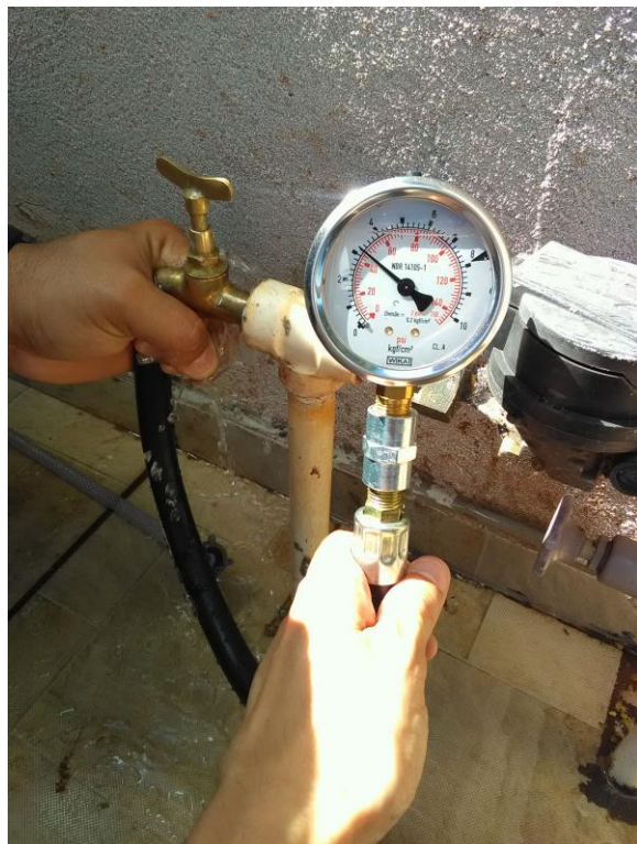
Imagem 31: Medição de pressão na Rua 29 de Novembro
