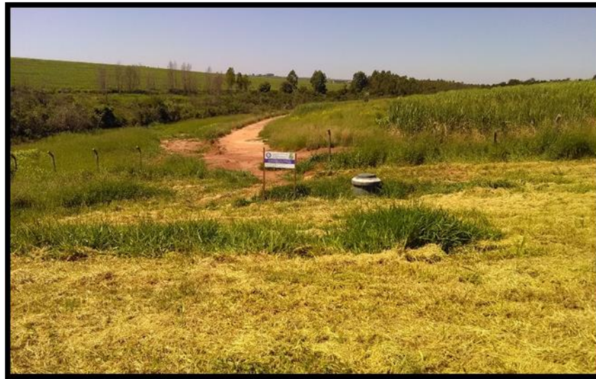
Imagem 41: Caixa de Saída da ETE
