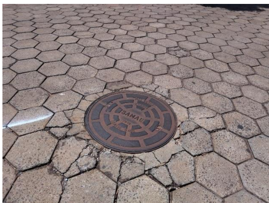
Foto 89: PV de esgoto.
