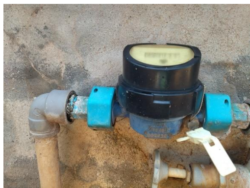
Foto 87: Ponto 03 – Ano de fabricação 2013. Foto 88: Ponto 03 – Pressão = 55 mca.
