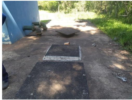
Foto 68: Reservatório e tampas.
