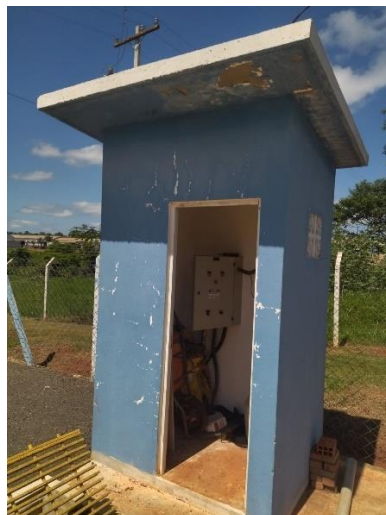
Foto 98: Casa de comando.
