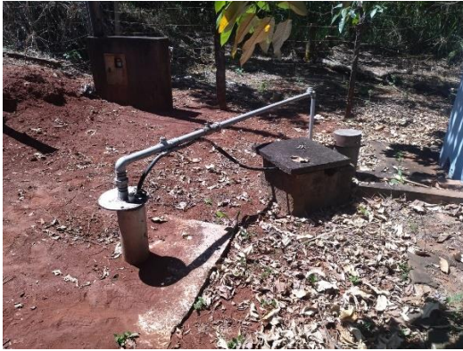
Foto 45: Instalações do poço. Foto 46: Falta de tomada de coleta.
