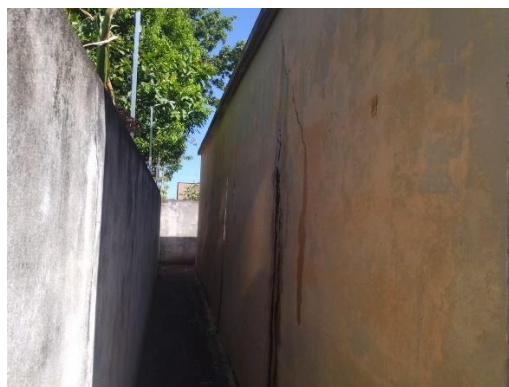
Foto 75: Vazamentos aparentes.
