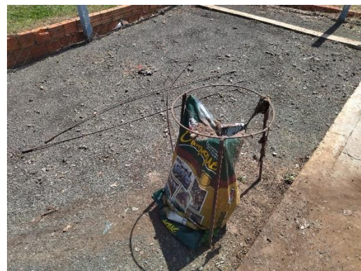
Foto 96: Local de armazenamento de lodo.
