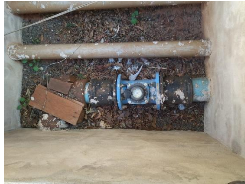
Foto 76: Tampa de inspeção. Foto 77: Macromedidor de entrada (poço 03).
