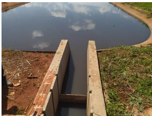
Foto 107: Dispositivo de saída (lagoa anaerobia 01).
