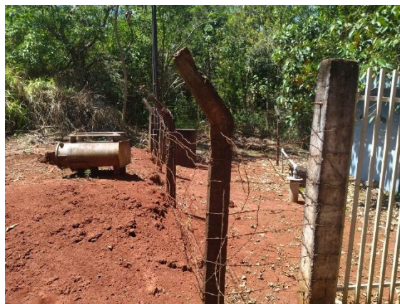
Foto 47: Falta de cercamento adequado.
