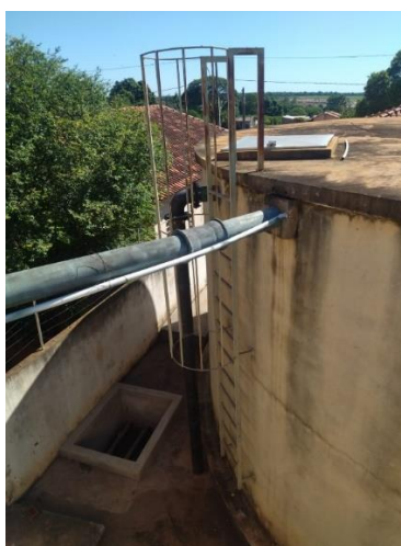
Foto 82: Tampas de inspeção e escadas/guarda -corpo.
