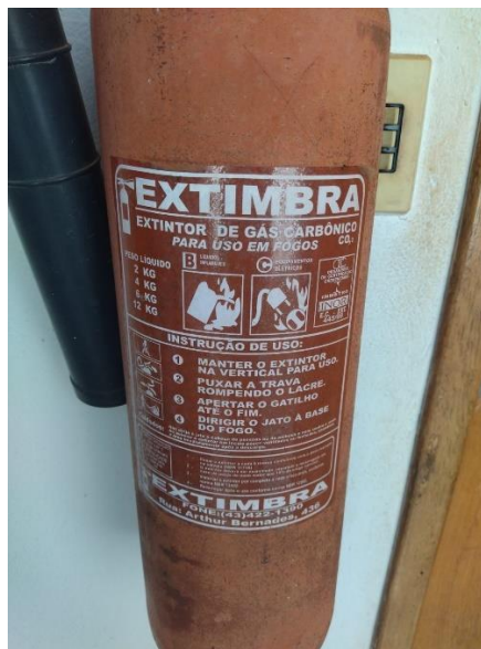
Foto 29: Extintor de incêndio. Foto 30: Falta de tarja de identificação de validade.
