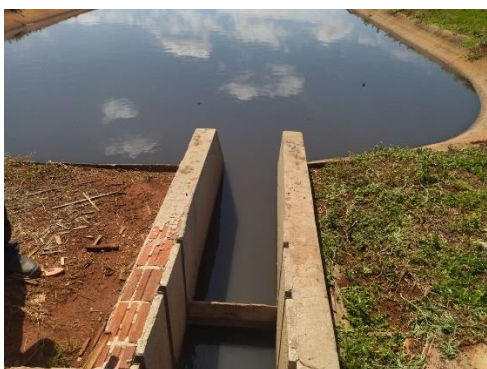
Foto 111: Dispositivo de saída (lagoa anaeróbia 02).
