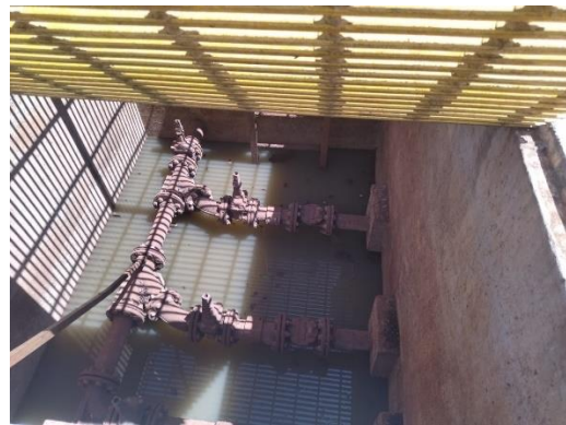
Foto 94: Vazamentos aparentes.
