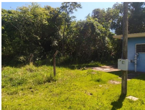
Foto 54: Falta de cercamento adequado.
