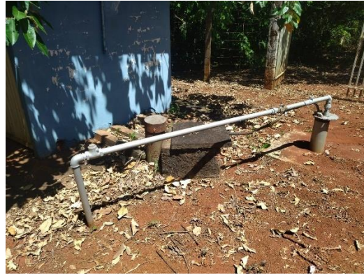
Foto 45: Instalações do poço. Foto 46: Falta de tomada de coleta.
