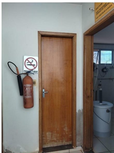
Foto 29: Extintor de incêndio. Foto 30: Falta de tarja de identificação de validade.
