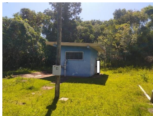
Foto 51: Falta de iluminação externa.
