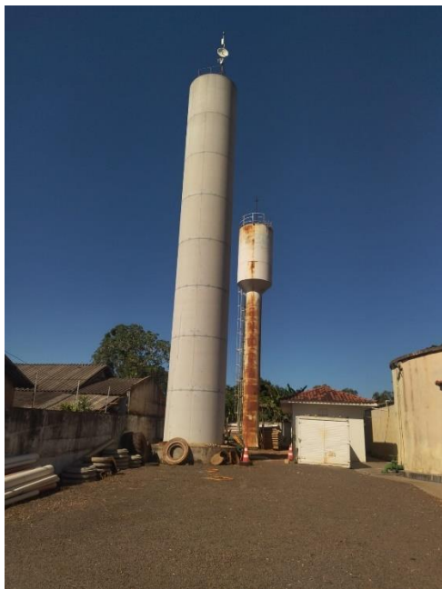
Foto 71: Falta de identificação. Foto 72: Falta de guarda corpo na tampa de inspeção (superior).
