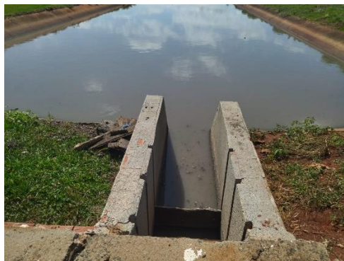
Foto 111: Dispositivo de saída (lagoa anaeróbia 02).
