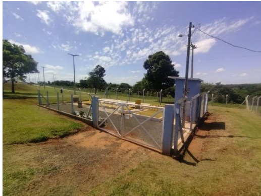
Foto 93: Falta de identificação de acesso.
