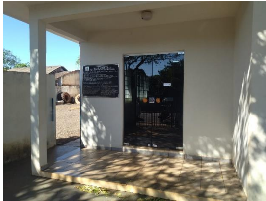
Foto 01: Fachada – Falta de informações de horários.
