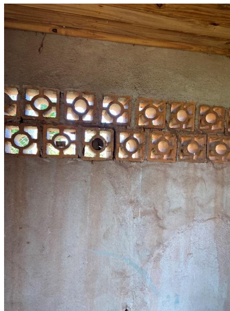
Foto 41 – Parte Interna do Abrigo
