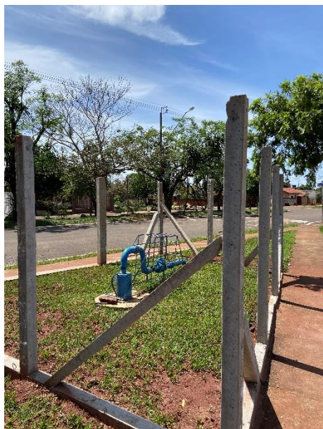
Foto 40 – Poço 03 construção do isolamento
