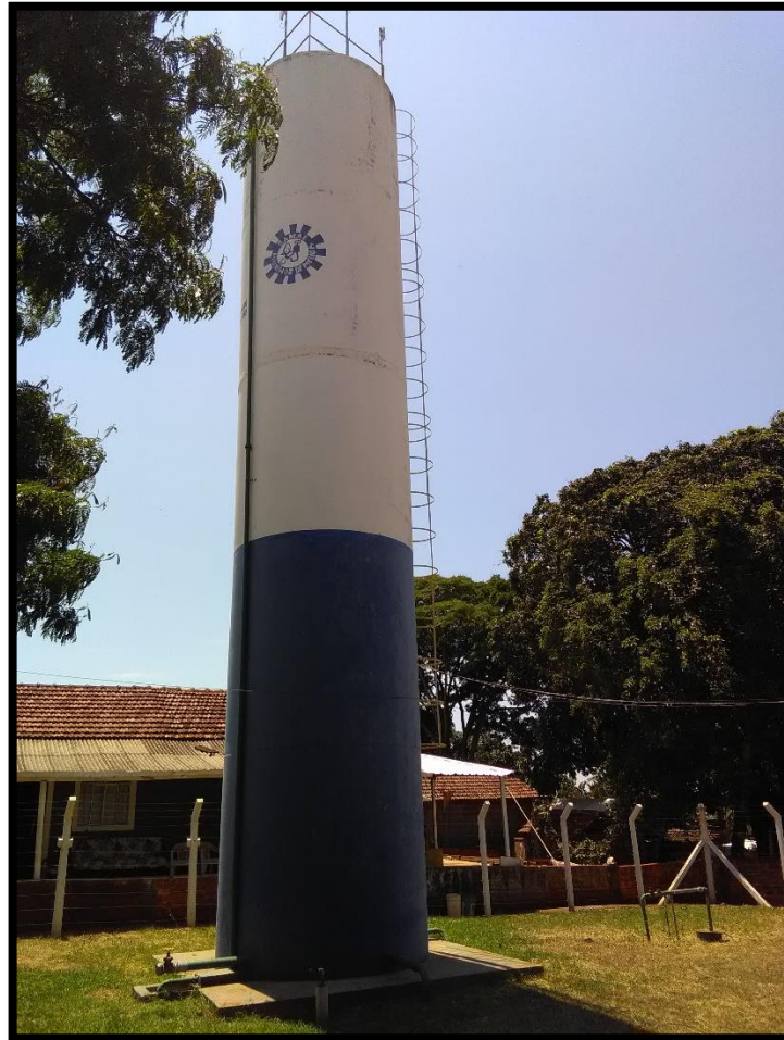
Imagem 17: Reservatório elevado do Distrito
