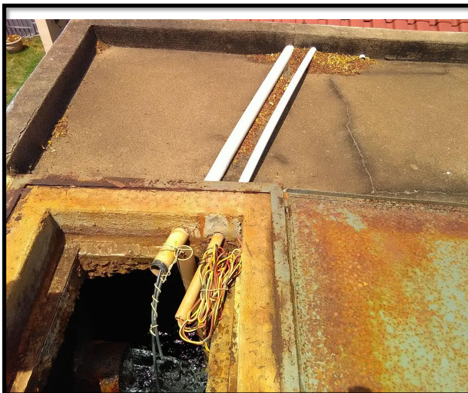
Imagem 10: Abertura de inspeção do reservatório apoiado
