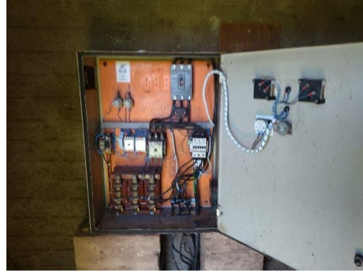
Foto 31:Quadro de comando. Foto 32: Falta de diagrama unifilar.
