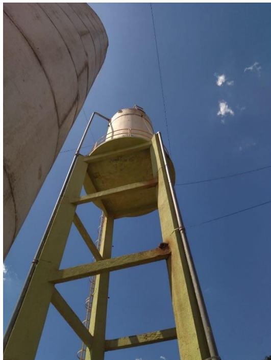
Foto 49: Asusencia de para raios e identificação.
