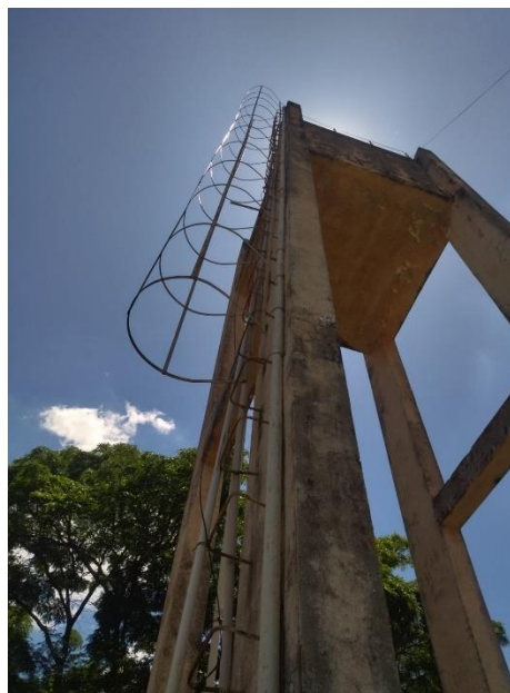
Foto 38: Ausência de para raios, aterramento e conservação. Foto 39: Escadas.
