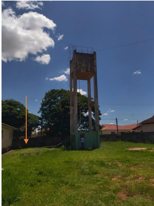
Foto 18: Falta de proteção do poço.
