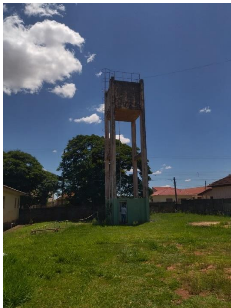
Foto 38: Ausência de para raios, aterramento e conservação. Foto 39: Escadas.
