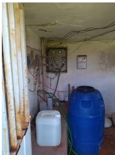
Foto 43: Sistema de tratamento (desinfecção).
