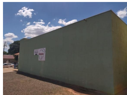
Foto 47: Vista geral (reservatório).
