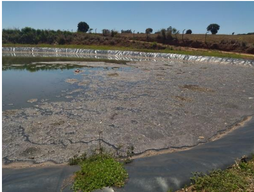
Foto 61: Lodo em superfície Lagoa Anaerobia.
