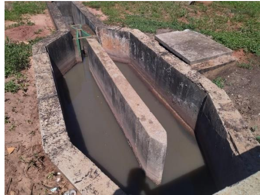
Foto 60: Desarenador operando sem interrupção uma de passagem para limpeza.
