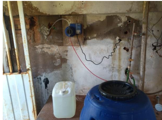
Foto 40: Ausência de identificação e finalidade do reservatório. Foto 41: Sistema de tratamento independente do reservatório.
