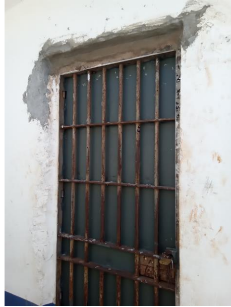
Foto 77 – Casa de comando
