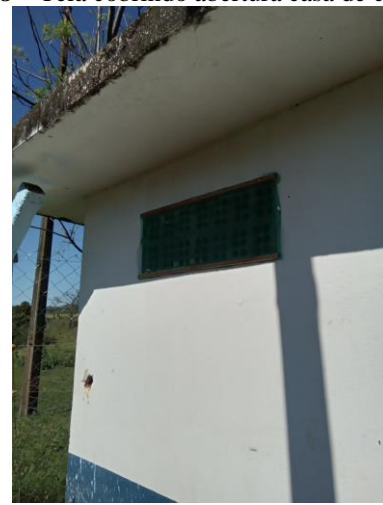
Foto 18 – Tela cobrindo abertura casa de comando
