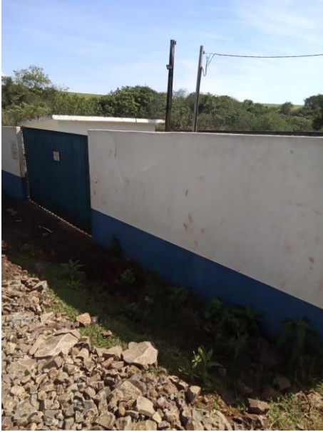
Foto 72 – Acesso poço 5 – Raposo Tavares
