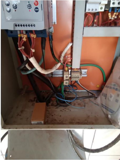
Foto 40 – Limpeza quadro de comando poço São Paulo
