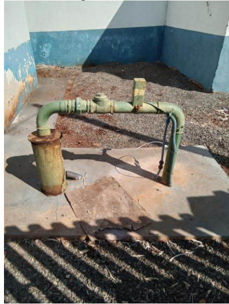
Foto 21 – Poço São José 3
