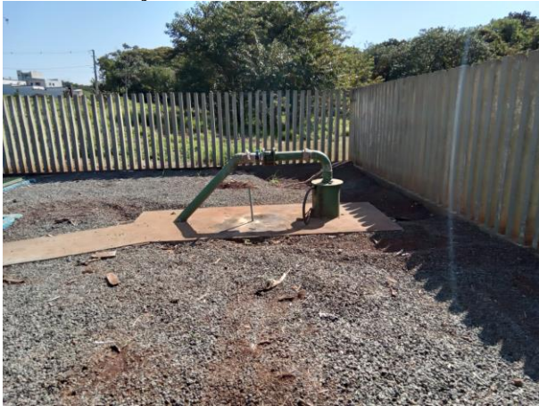
Foto 24 – Poço São José 3
