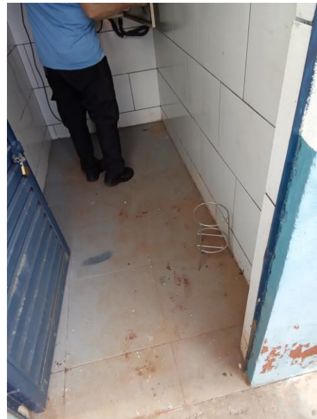
Foto 47 – Limpeza casa de comando poço Paulista
