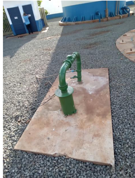
Foto 67 – Poço São Pedro
