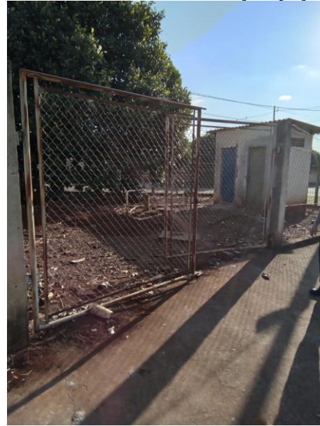
Foto 77 – Falta de identificação poço Mauá
