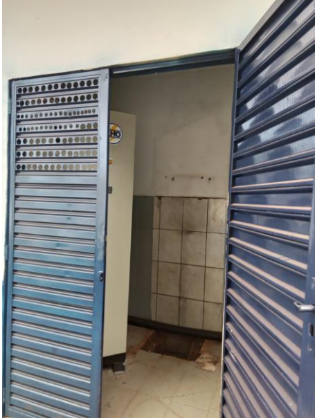
Foto 52 – Entrada casa de comando poço Vitória
