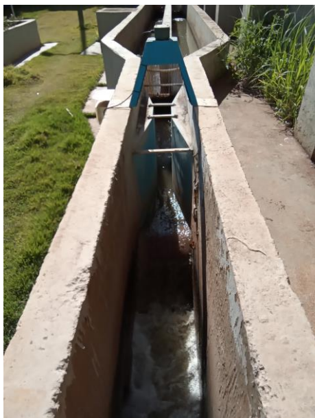
Foto 126 – Gradeamento, desarenador e calha Parshall EEE Centro Cívico
