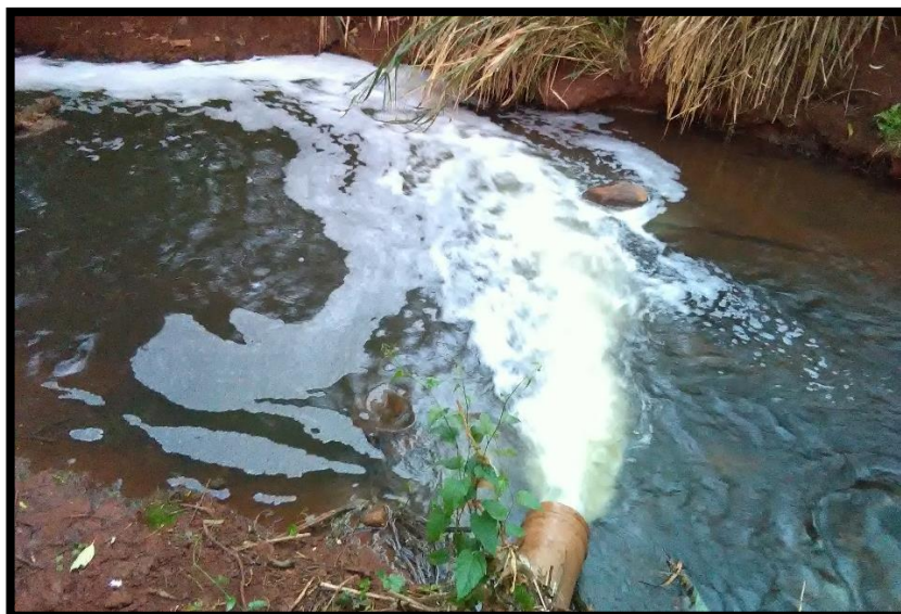
Imagem 49: Emissário de efluente no corpo receptor
