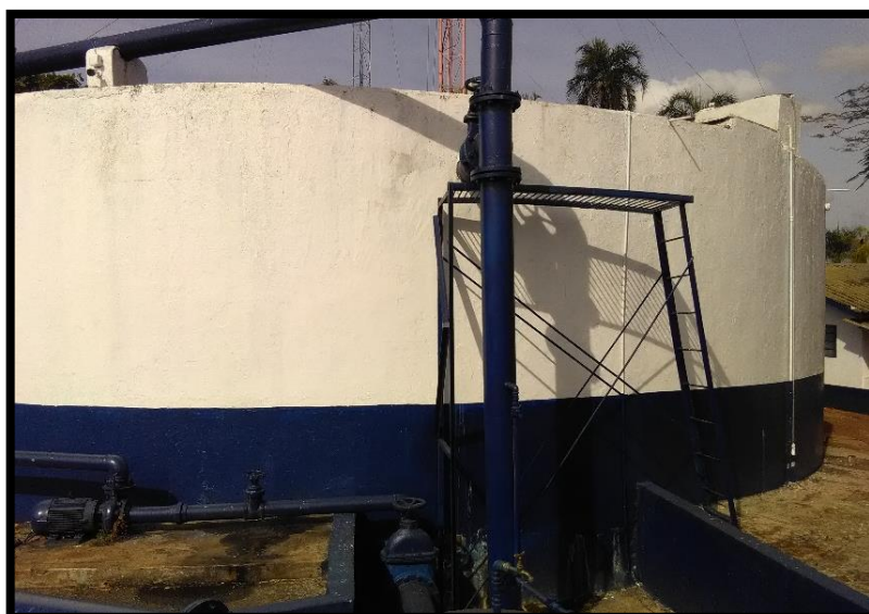
Imagem 16: Reservatório apoiado de 600 m 3
