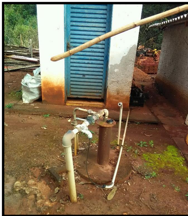
Imagem 39: Poço do Conjunto Tibagi II
