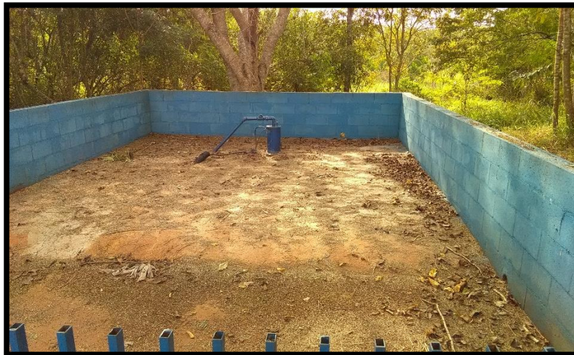
Imagem 26: Poço 2 do Setor Leste
