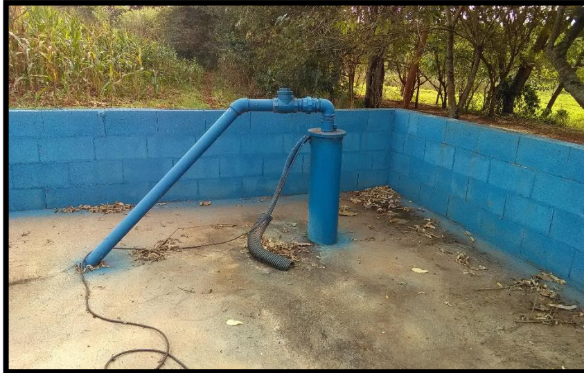
Imagem 25: Poço 1 do Setor Leste
