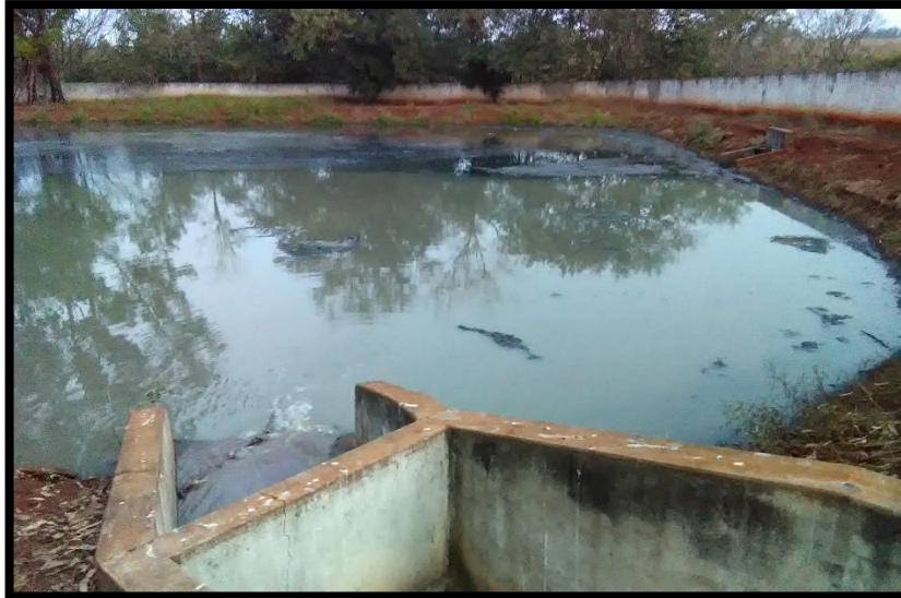
Imagem 47: ETE – Lagoa Anaeróbia
