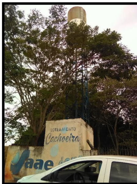
Imagem 43: Reservatório elevado do Conjunto Cachoeira
