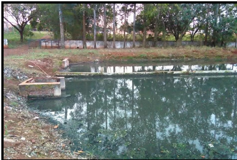
Imagem 48: ETE – Lagoa Facultativa
