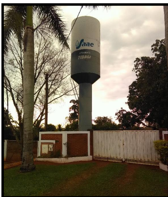
Imagem 41: Reservatório elevado do Conjunto Tibagi II
