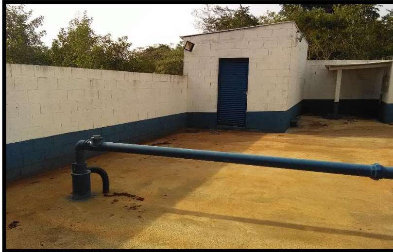
Imagem 28: Poço 4 do Setor Leste
