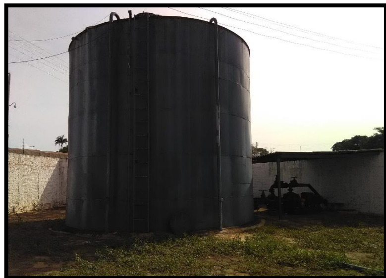
Imagem 19: Reservatório apoiado de água bruta da Zona Sul
