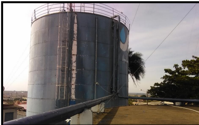
Imagem 14: Reservatório apoiado de 200 m 3
