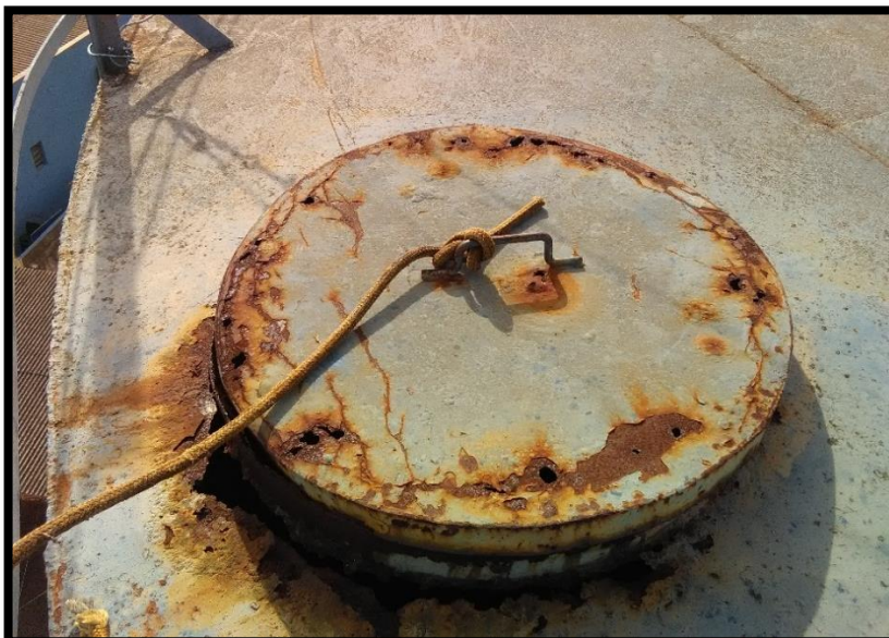
Imagem 15: Reservatório apoiado de 1200 m 3 – abertura de inspeção
