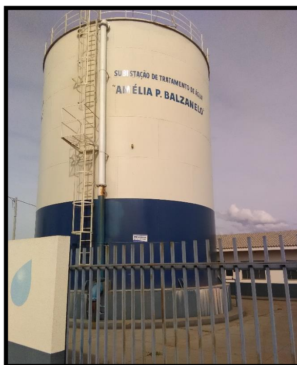
Imagem 32: Reservatório apoiado do Setor Leste
