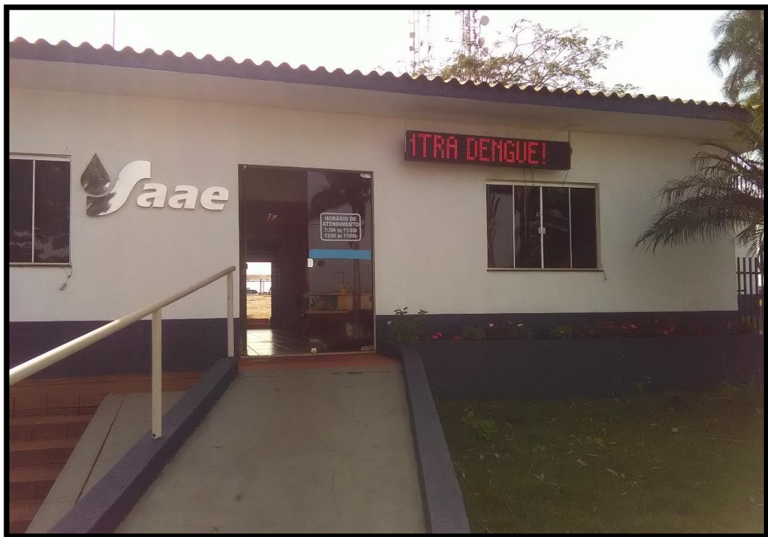
Imagem 1: Fachada área comercial
