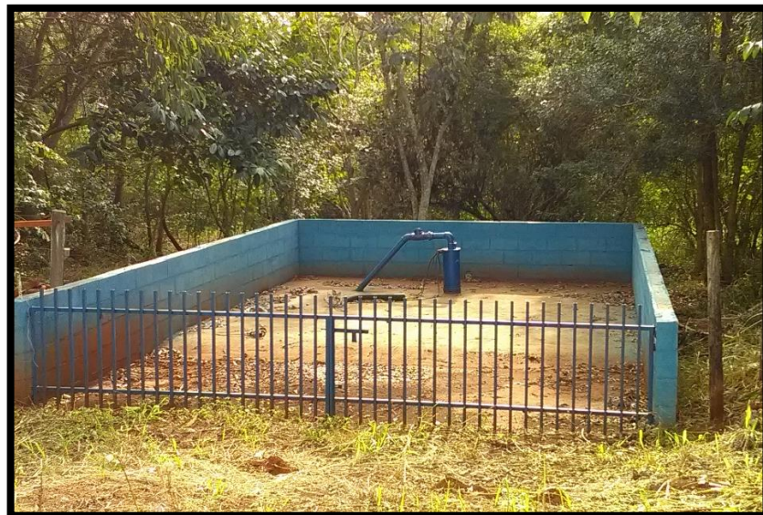
Imagem 27: Poço 3 do Setor Leste
