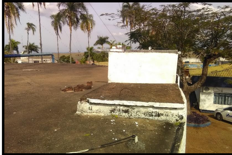
Imagem 17: Reservatório apoiado de 600 m 3 - Abertura de inspeção
