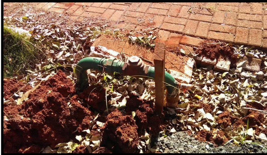
Imagem 10: Poço Cine Teatro
