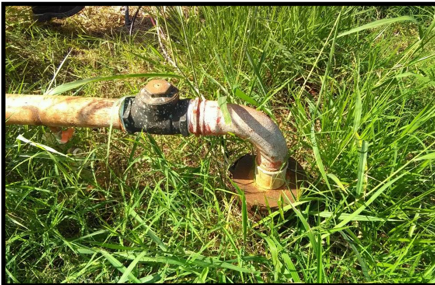
Imagem 11: Poço linha Férrea
