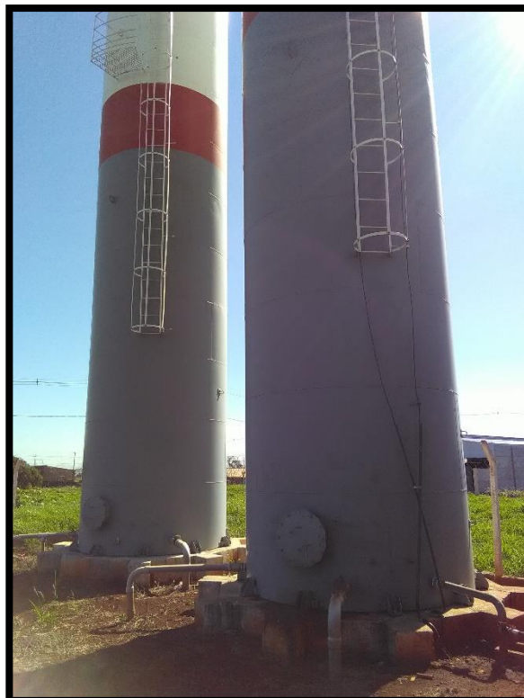
Imagem 68: Reservatórios Polessi 1 e 2
