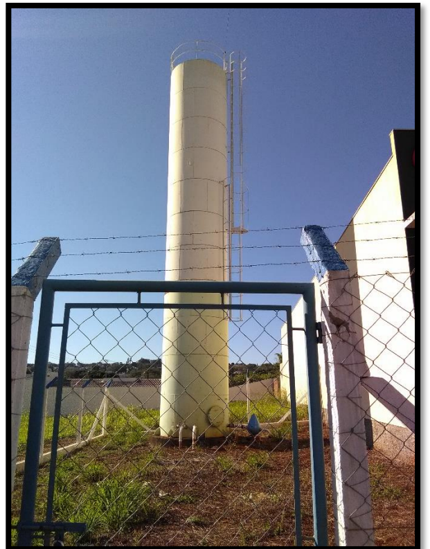
Imagem 62: Reservatório São Pedro
