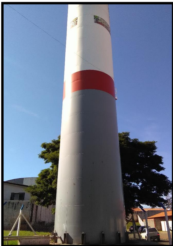
Imagem 65: Reservatório João de Barro
