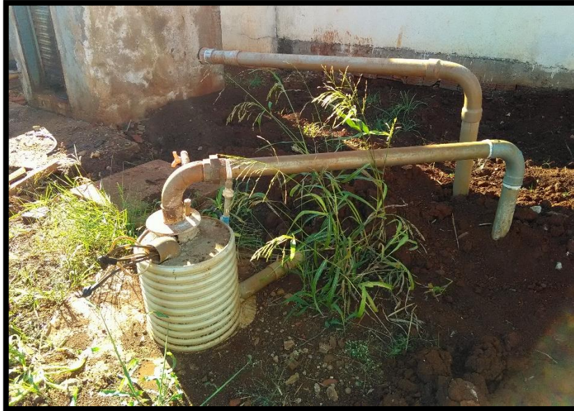
Imagem 28: Poço Vila Brasil
