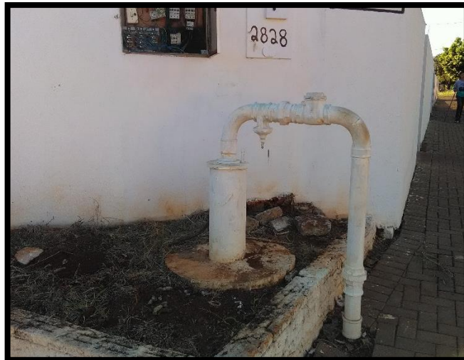
Imagem 19: Poço Pq Palmeiras
