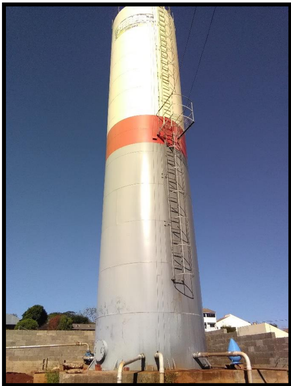
Imagem 75: Reservatório Novo Horizonte
