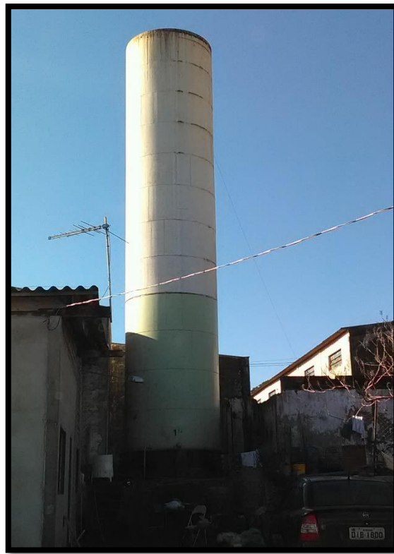
Imagem 76: Reservatório Zé doce
