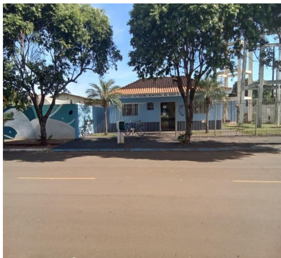
Foto 1 – Fachada do SAMAE de Jardim Olinda
