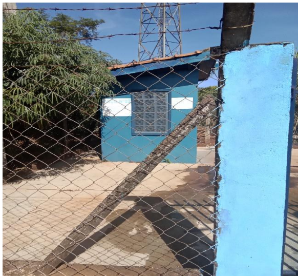
Foto 75 – Entrada do poço com identificação
