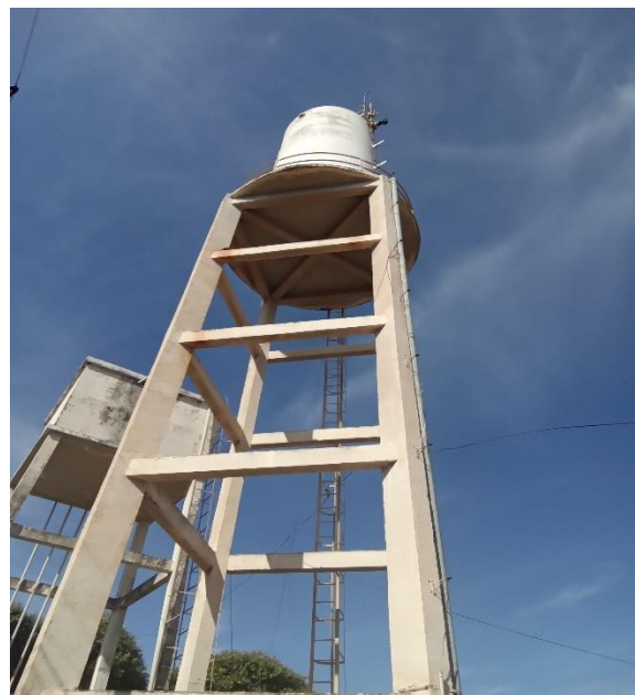
Foto 40 – Sistema de aterramento REL
