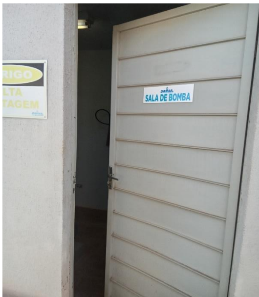
Foto 22 – Identificação sala de bomba
