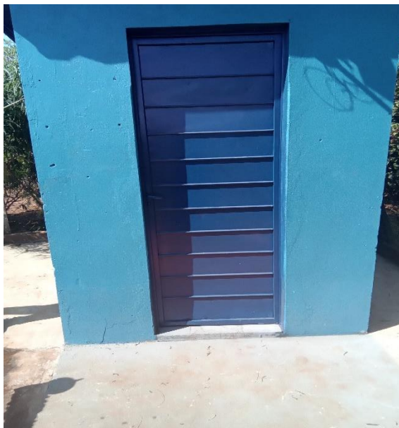
Foto 17 – Acesso ao quadro de comando
