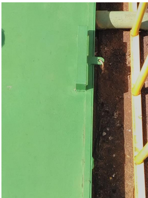
Foto 42 – Abertura acesso RAP 02
