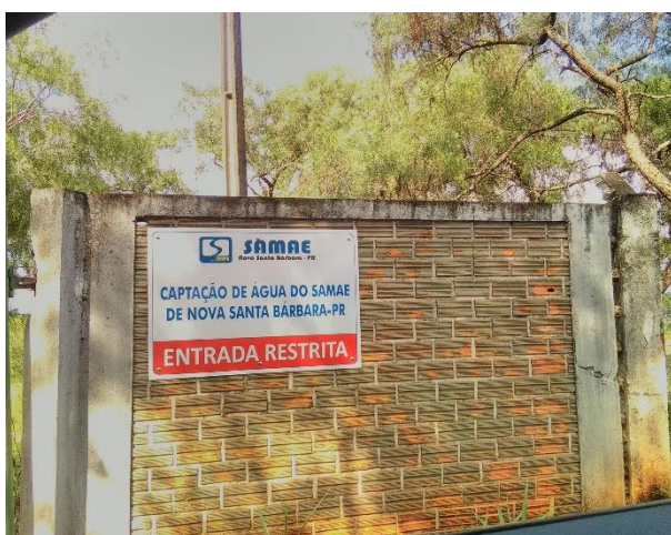
Foto 15 – Entrada captação minas e poço 02
