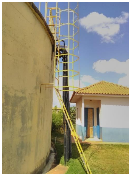
Foto 33 – Escada de acesso RAP 02
