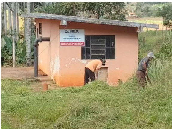
Foto 45 – Unidade da elevatória de água bruta
