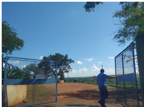
Foto 65 – Acesso secundário ETE
