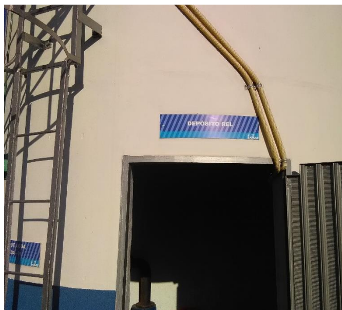
Foto 31 – Depósito do reservatório elevado
