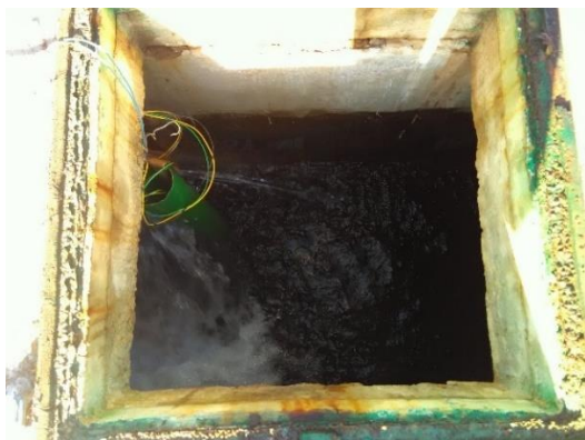
Foto 38 – Parte interna reservatório apoiado
