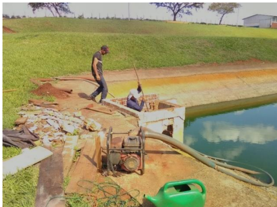
Foto 70 – Reforma saída lagoa anaeróbia 02
