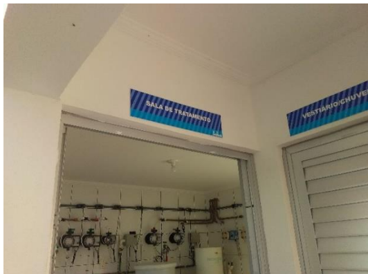
Foto 22 – Identificação da unidade de tratamento
