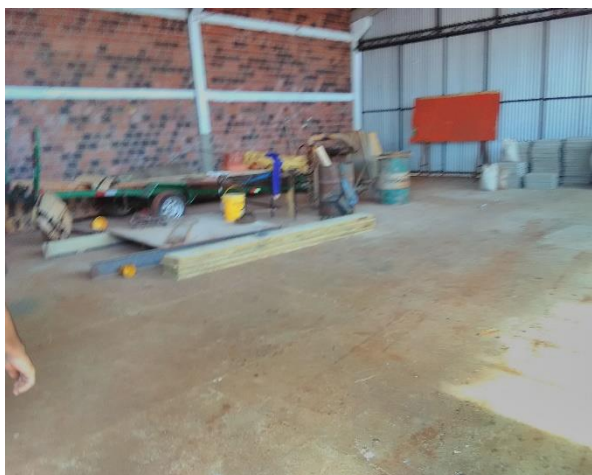
Foto 78 – Barracão de apoio e almoxarifado ETE Foto 79 – BWC's para funcionários ETE
