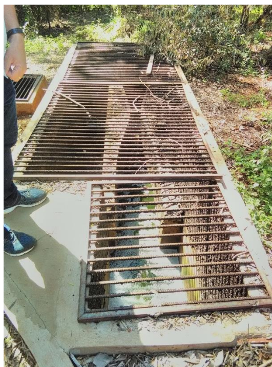
Foto 73 – Calha Parshall (saída)
