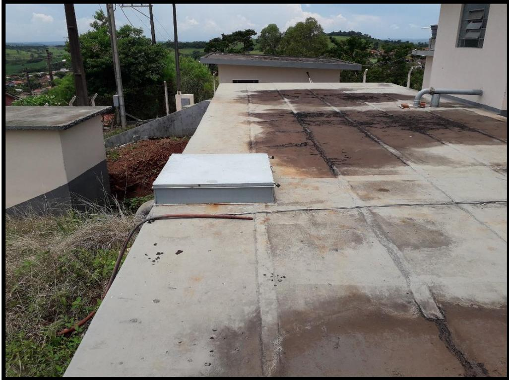
Imagem 11: Abertura de inspeção do reservatório enterrado
