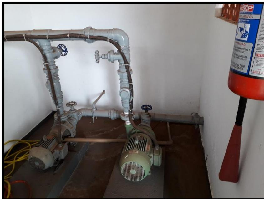
Imagem 21: Instalação conjunto motobombas do booster
