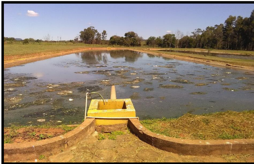
Imagem 30: ETE – Lagoa Anaeróbia
