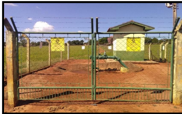
Imagem 10: Poço 04 – Isolamento do perímetro e sinalização
