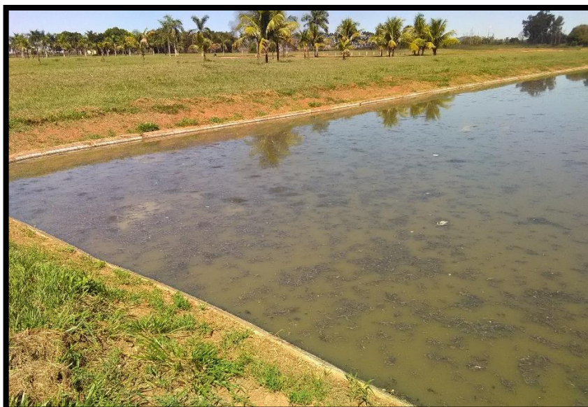
Imagem 31: ETE – Lagoa facultativa
