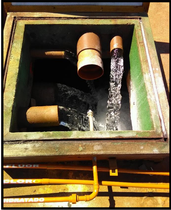
Imagem 21: RSE 01 – abertura de inspeção
