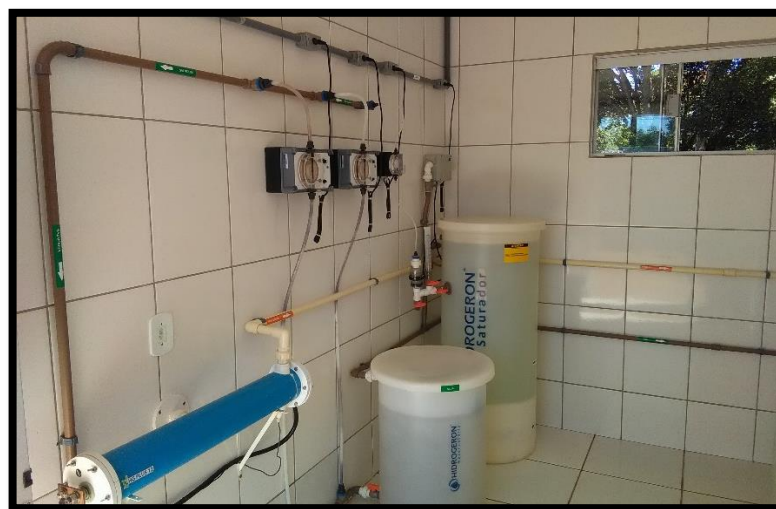
Imagem 16: Estação de tratamento convencional – bombas dosadoras e reservatórios de sal e água
