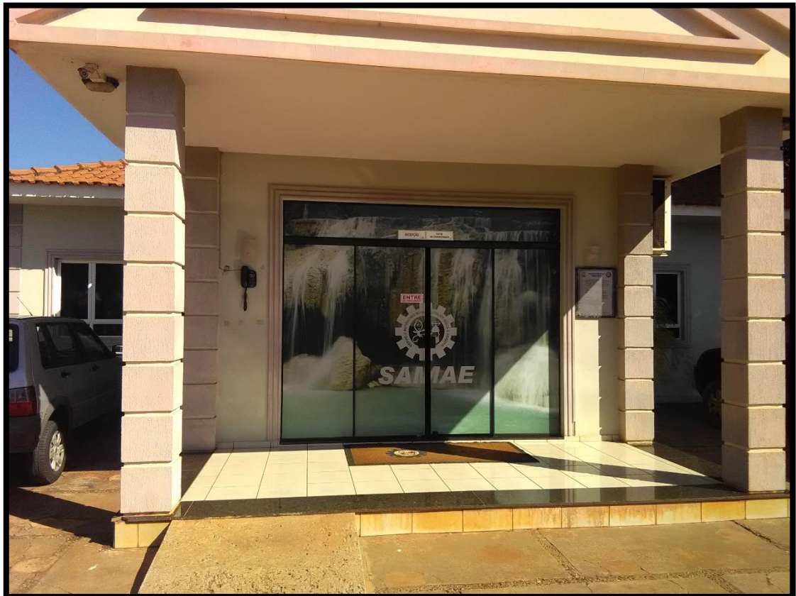
Imagem 1: Entrada área comercial
