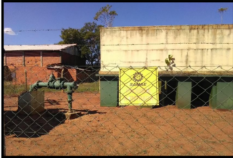
Imagem 6: Poço 01 – isolamento do perímetro e restrição de acesso
