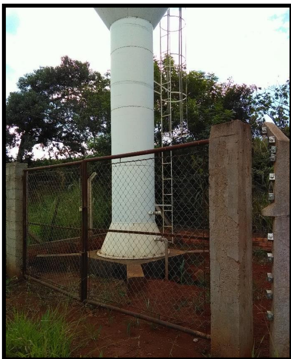
Imagem 28: Reservatório elevado – Vila Nova
