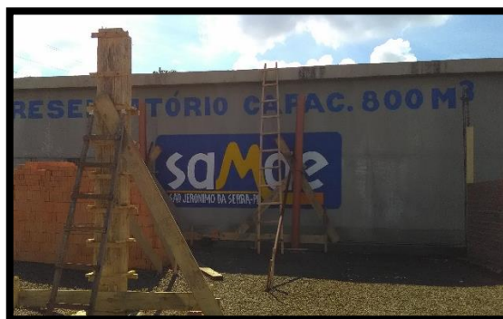
Imagem 25: Reservatório apoiado - Sede
