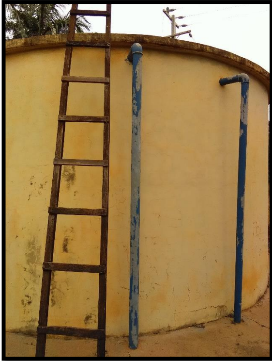
Imagem 30: Reservatório apoiado – Poço Terra Nova
