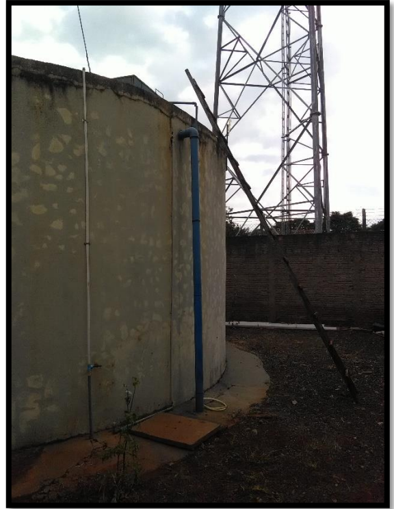
Imagem 31: Reservatório apoiado – Terra Nova
