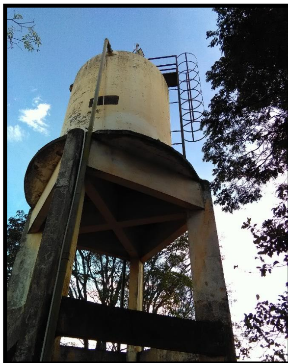
Imagem 29: Reservatório elevado – Vila Nova
