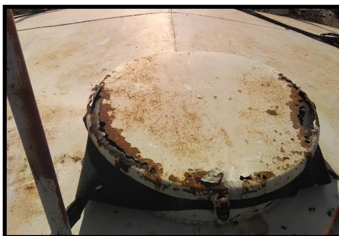
Imagem 14: Reservatório elevado 01 – abertura de inspeção
