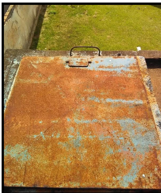
Imagem 10: Reservatório apoiado 01 – abertura de inspeção
