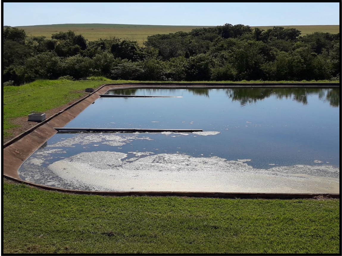
Imagem 34: ETE – Entrada da Lagoa Facultativa
