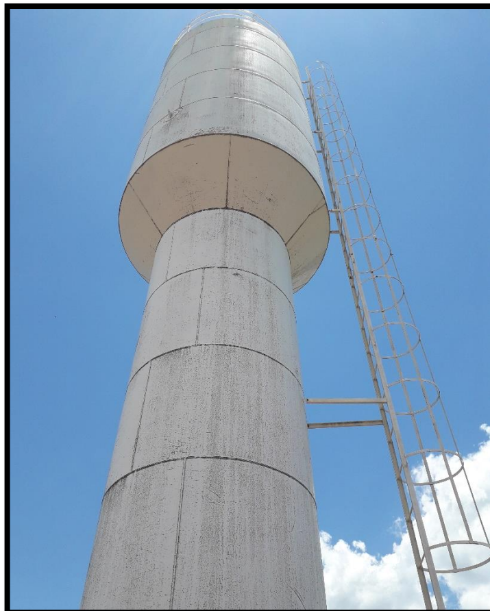
Imagem 23: Reservatório elevado de 10m 3 do distrito Km14
