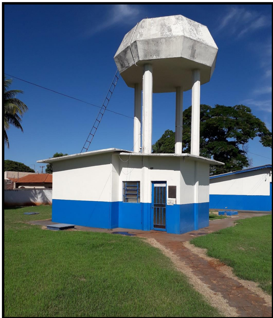
Imagem 17: Casa de bombeamento e reservatório elevado
