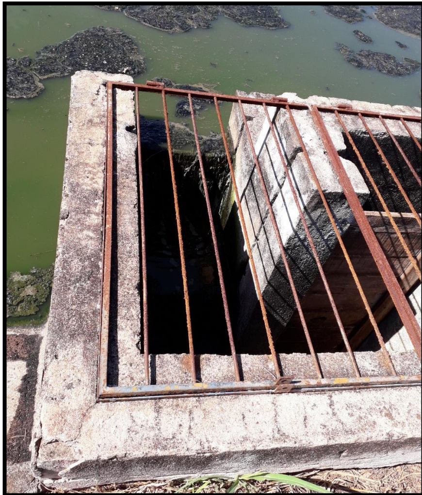
Imagem 33: ETE – Saída da Lagoa anaeróbia
