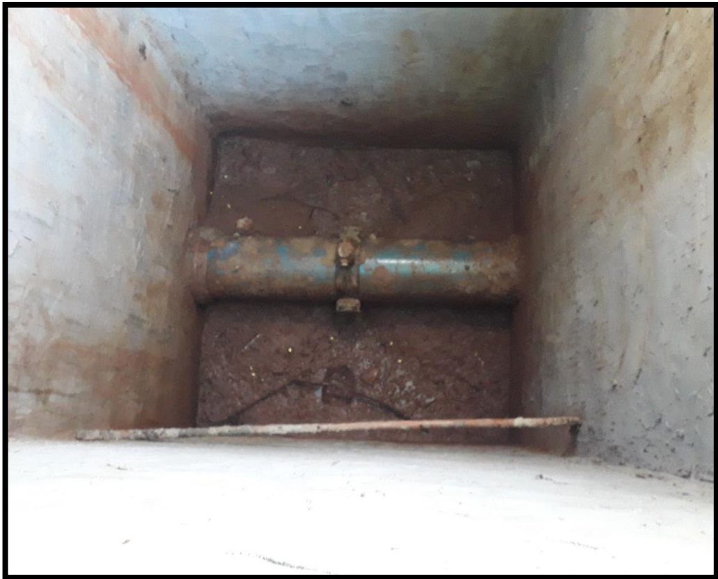
Imagem 10: Caixa para pitometria do Poço 01
