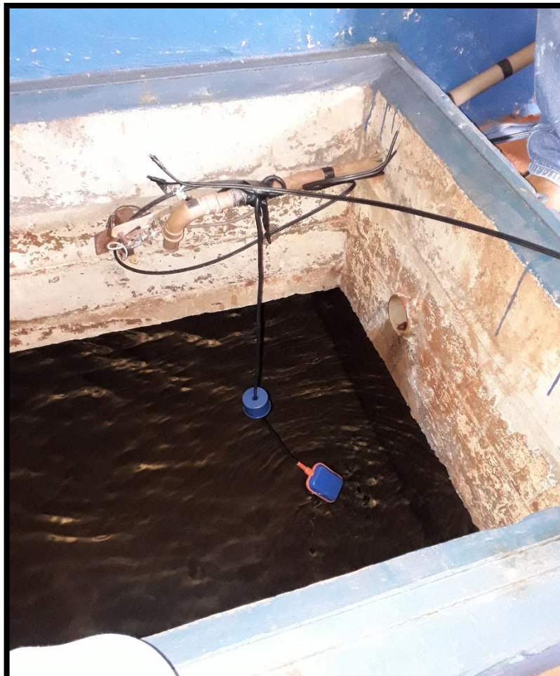
Imagem 19: Abertura de inspeção do reservatório enterrado de 650m 3
