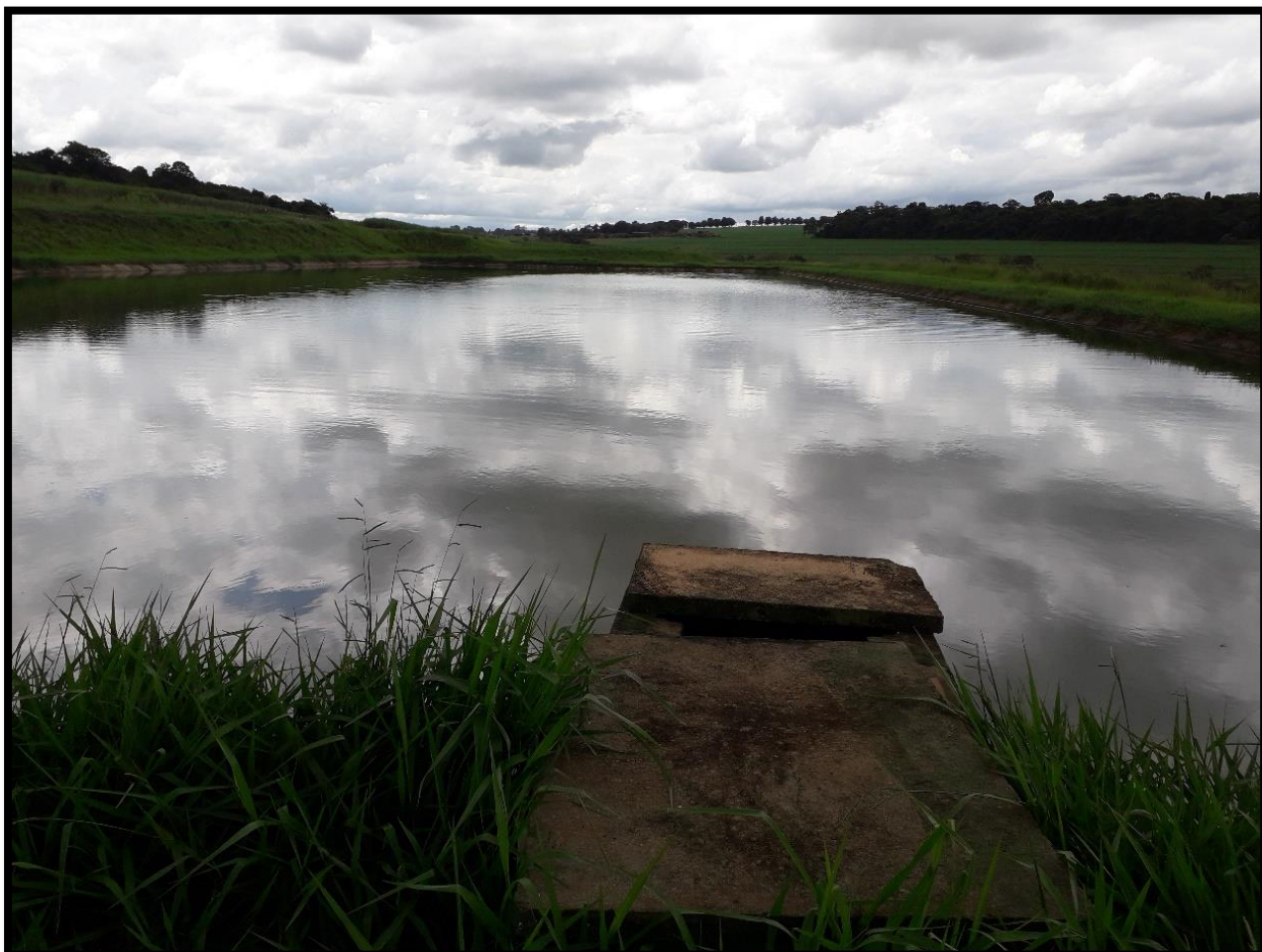
Imagem 48: ETE – Caixa de saída da lagoa facultativa
