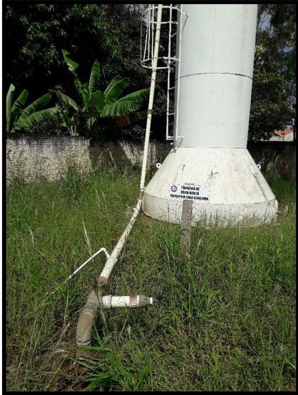
Imagem 12: Poço do sistema de abastecimento Horizonte
