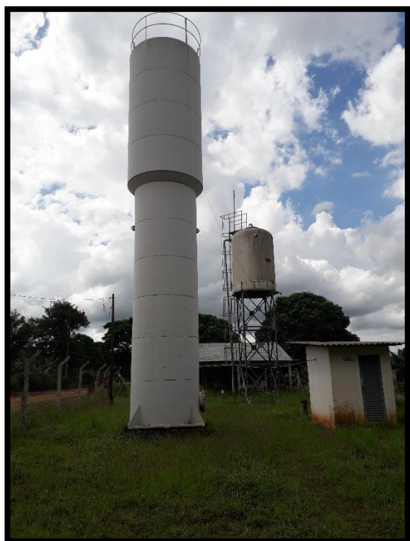
Imagem 35: Reservatório elevado – vila Avanci
