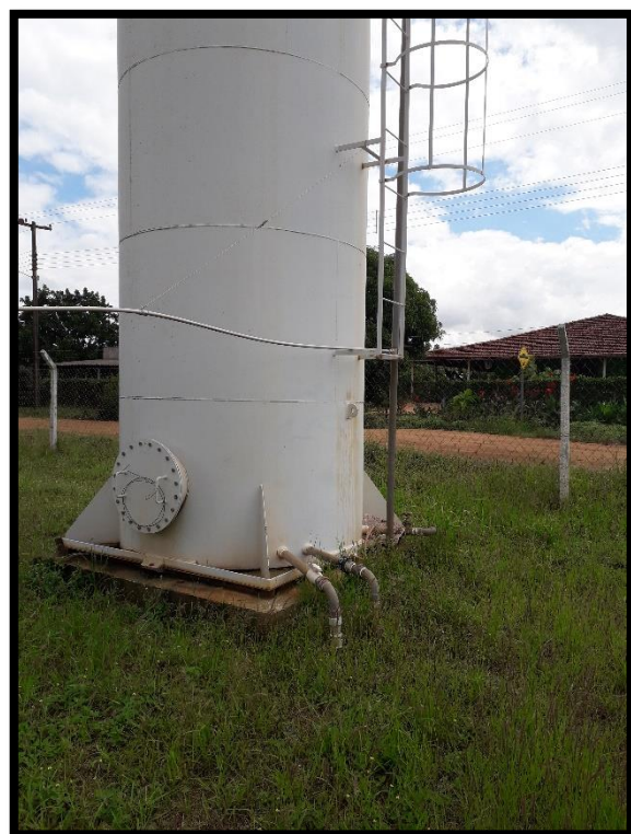
Imagem 36: Reservatório elevado – vila Avanci
