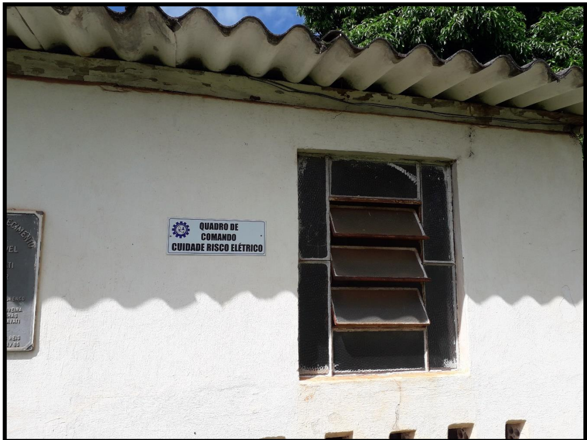
Imagem 14: Identificação do Quadro de comando do sistema de abastecimento Horizonte
