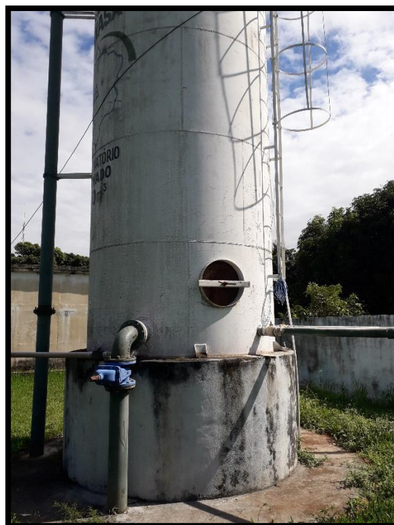
Imagem 32: Reservatório elevado – escada de acesso com gaiola de proteção
