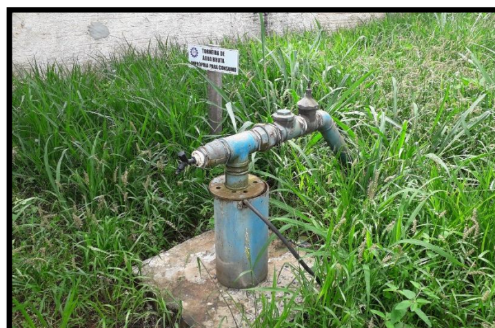
Imagem 8: Poço Milton – Instalação hidráulica
