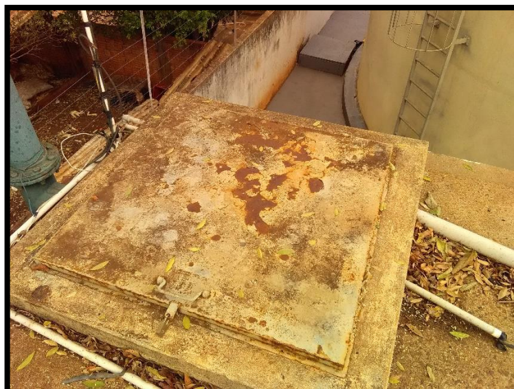
Imagem 11: Abertura de inspeção da Caixa 1
