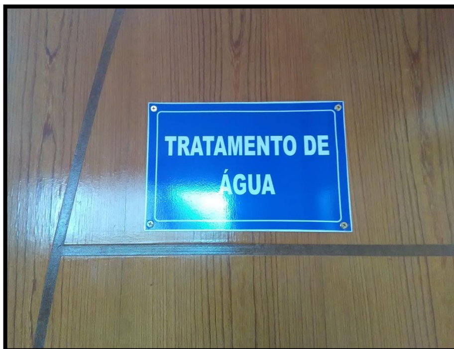
Imagem 8: Sinalização identificadora da Unidade de Tratamento de Água
