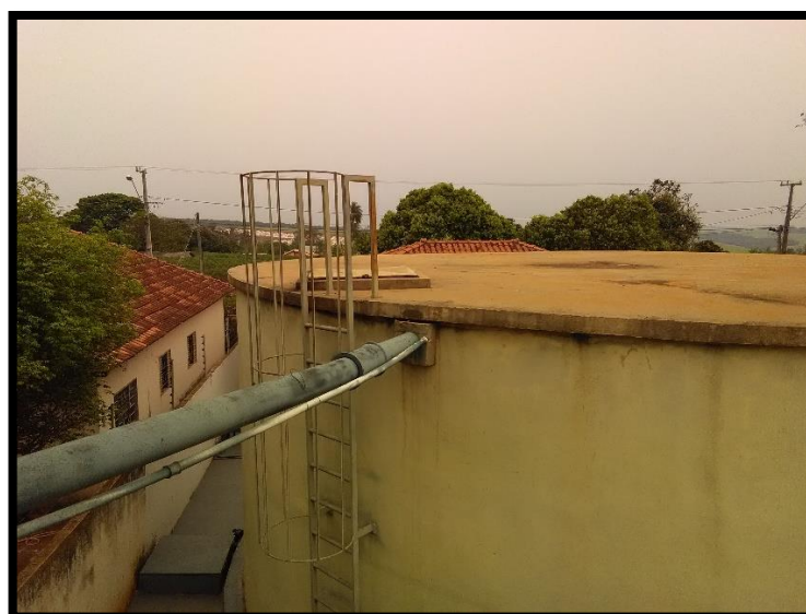
Imagem 13: Abertura de Inspeção da Caixa 2
