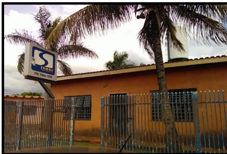
Imagem 1: Fachada área comercial
