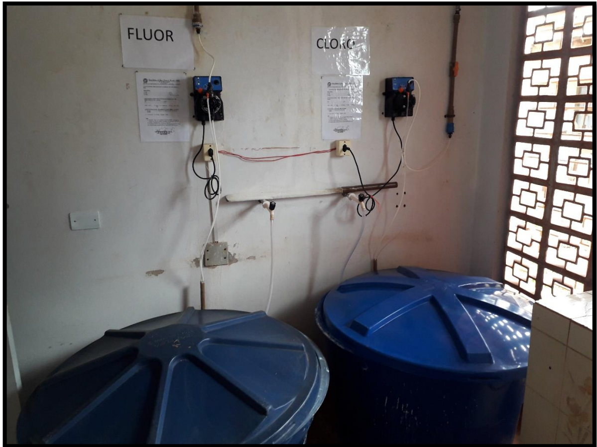
Imagem 17: Estação de tratamento simplificado
