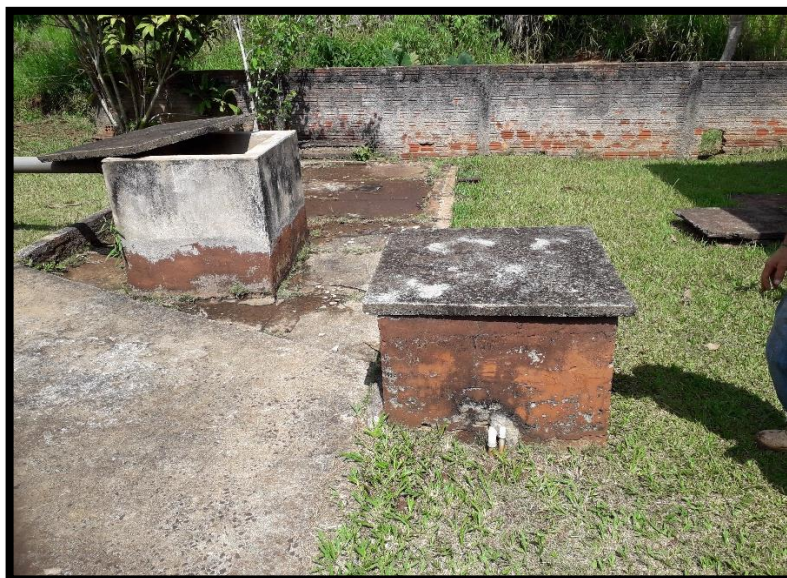
Imagem 8: Reservatório enterrado - Aberturas de inspeção em concreto
