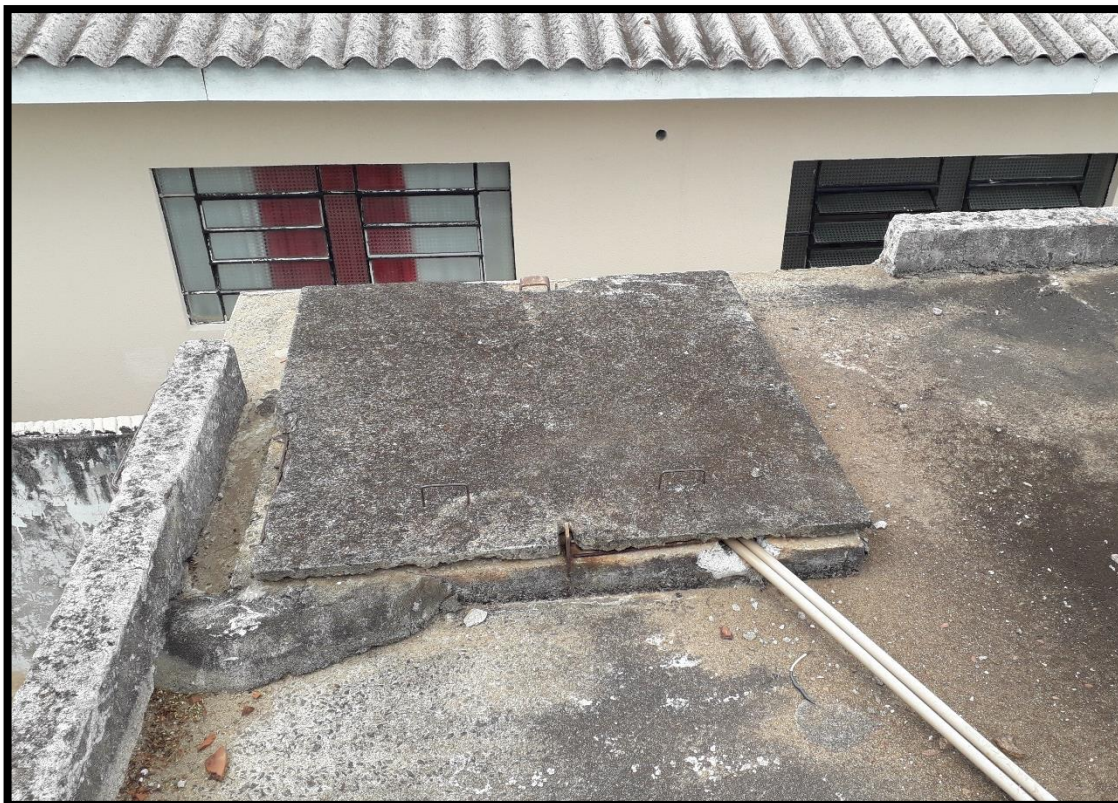
Imagem 11: Reservatório apoiado – Abertura de inspeção em concreto
