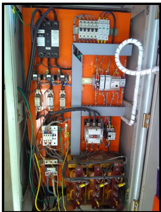
Imagem 8: Poço 02 – quadro de comando
