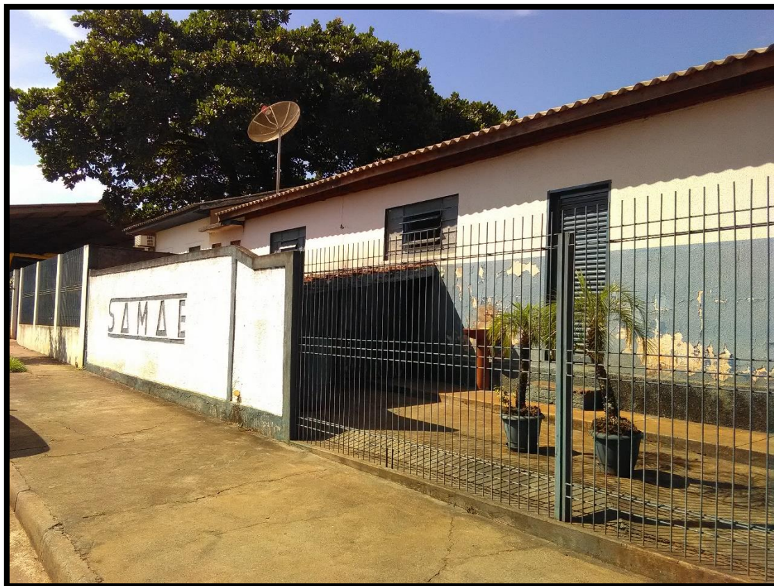
Imagem 1: Fachada área comercial
