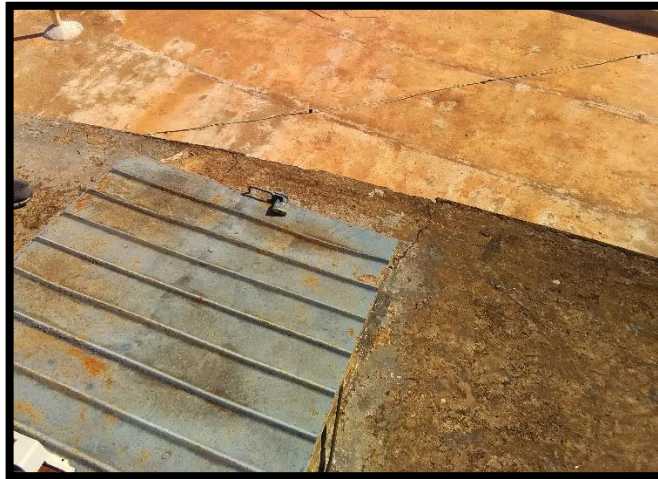
Imagem 14: Reservatório semienterrado – abertura de inspeção
