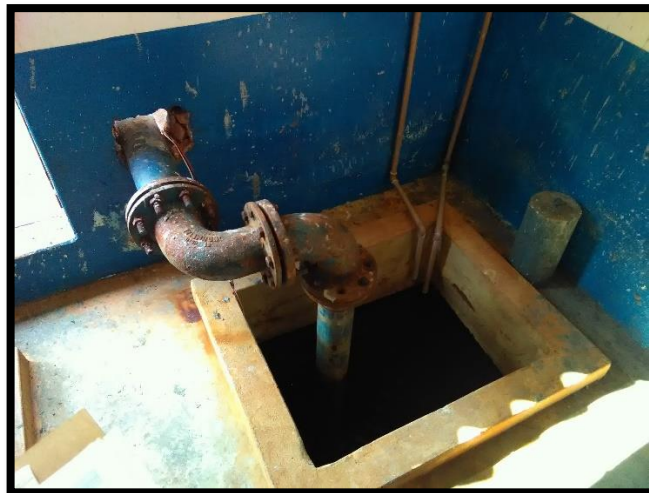
Imagem 15: Reservatório enterrado – abertura de inspeção
