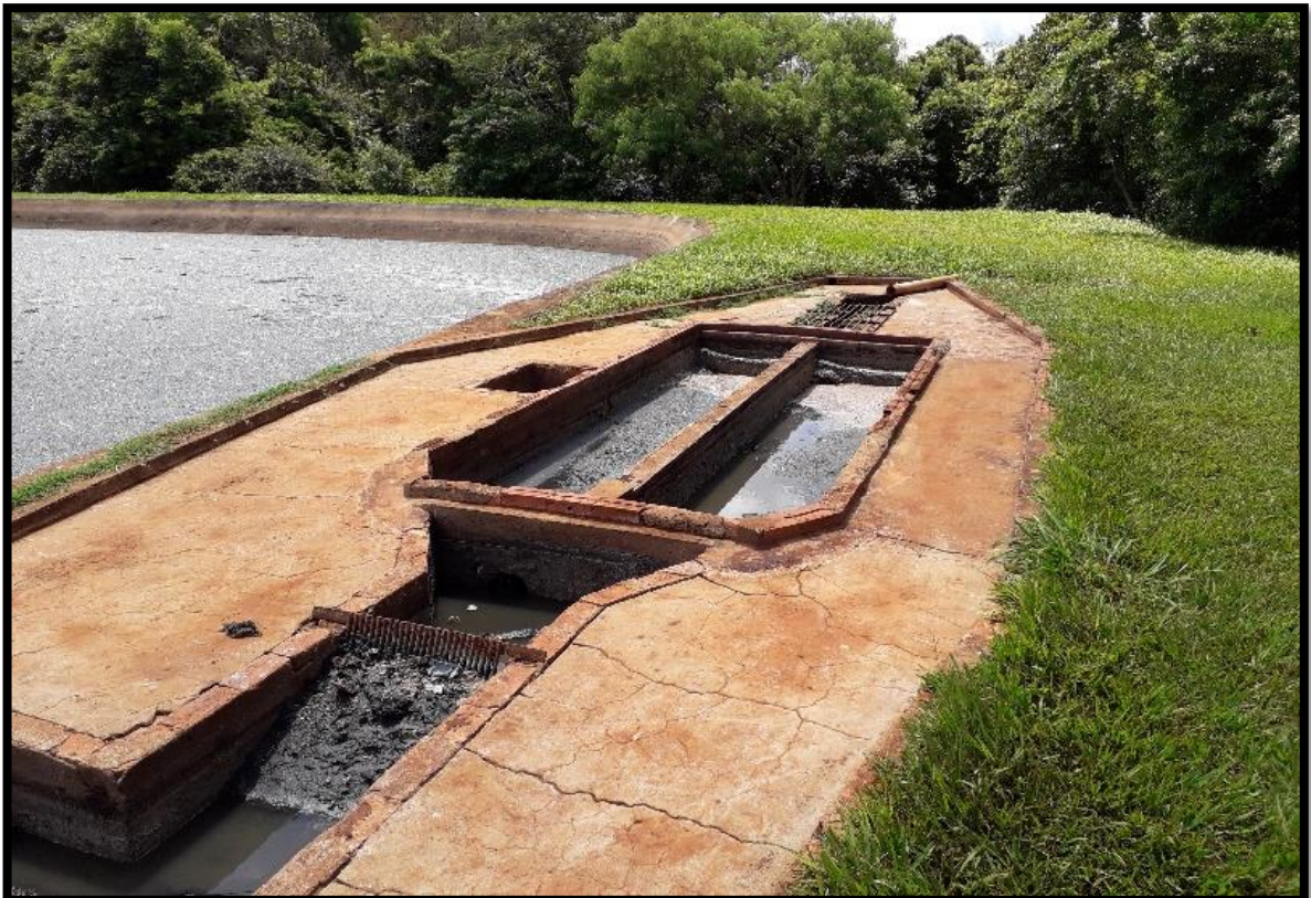
Imagem 58: ETE Augusto – Gradeamento, caixa de areia e medidor de vazão
