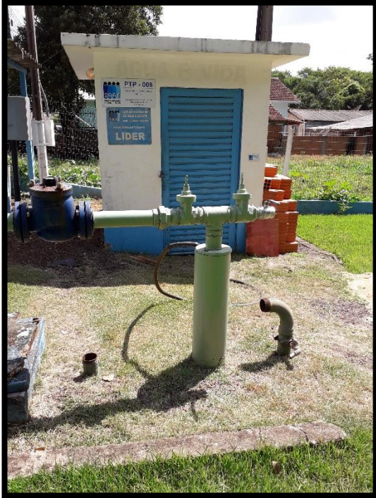
Imagem 9: PTP – 008 (Líder) – Instalação hidráulica
