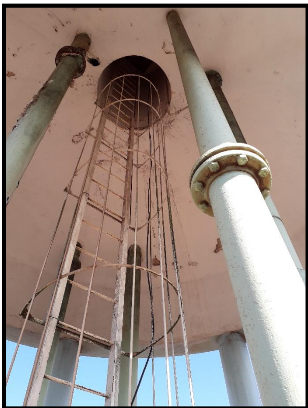
Imagem 23: REL – 001 – Escada de acesso
