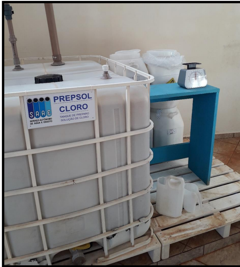
Imagem 16: Tanque de solução de cloro na Estação de tratamento simplificado aplicado no REN - 001
