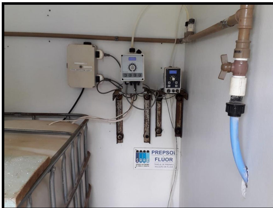
Imagem 20: Estação de tratamento simplificado junto ao REN – 006
