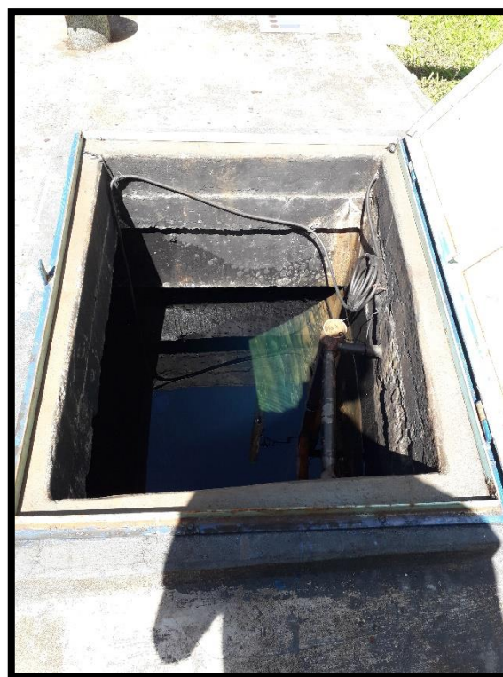
Imagem 34: REN – 005 – Abertura de inspeção
