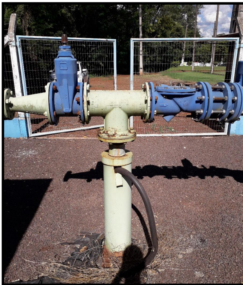
Imagem 12: PTP – 015 (Técnicos) – Instalação hidráulica
