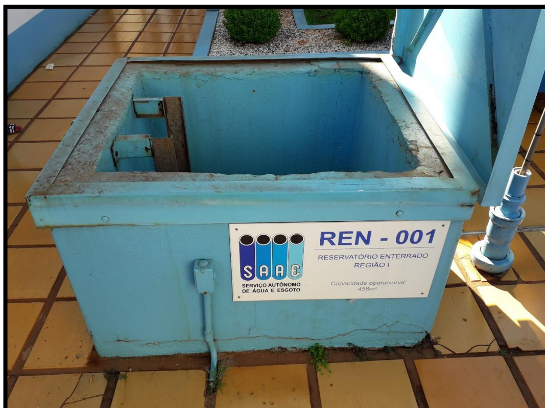
Imagem 22: REN – 001 - Abertura de inspeção
