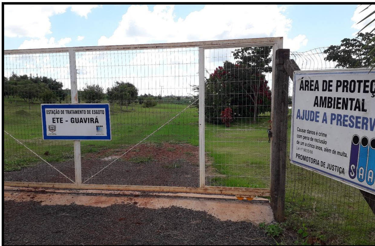
Imagem 61: ETE Guavirá – Entrada e Identificação
