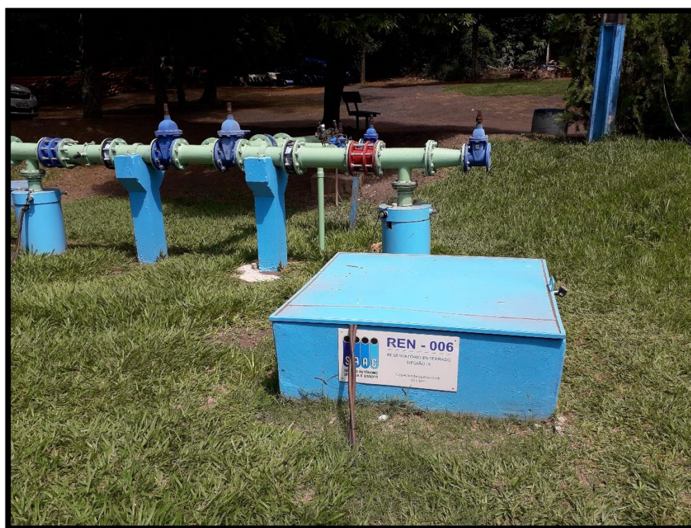
Imagem 30: REN – 006 – Abertura de inspeção
