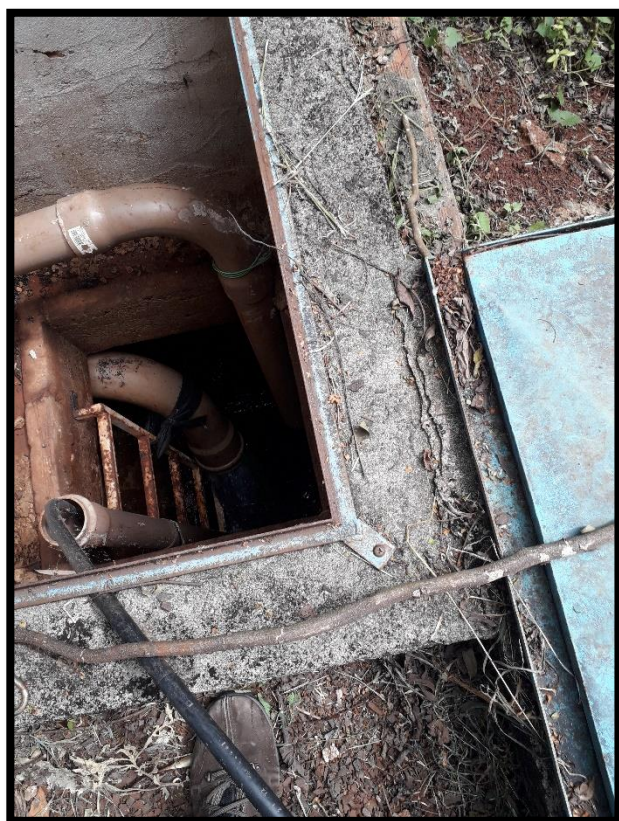
Imagem 38: REN – 003 – Abertura de inspeção
