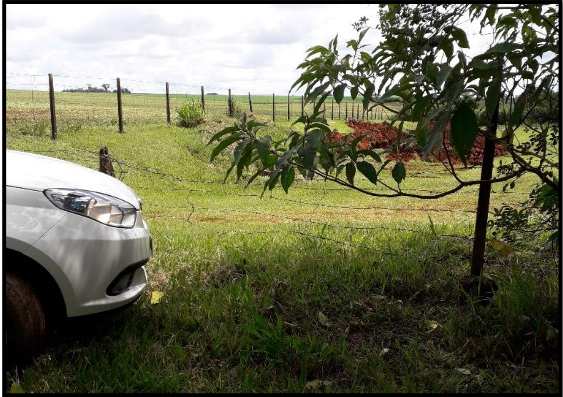
Imagem 57: ETE Augusto – Cerca de isolamento do perímetro
